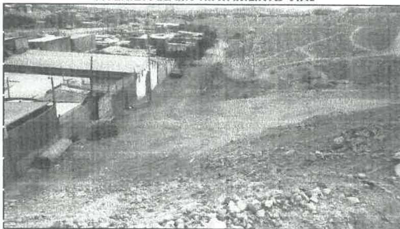
FOTOGRAFIA N° 001 AVENIDA 02 SIN TRATAMIENTO VIAL
