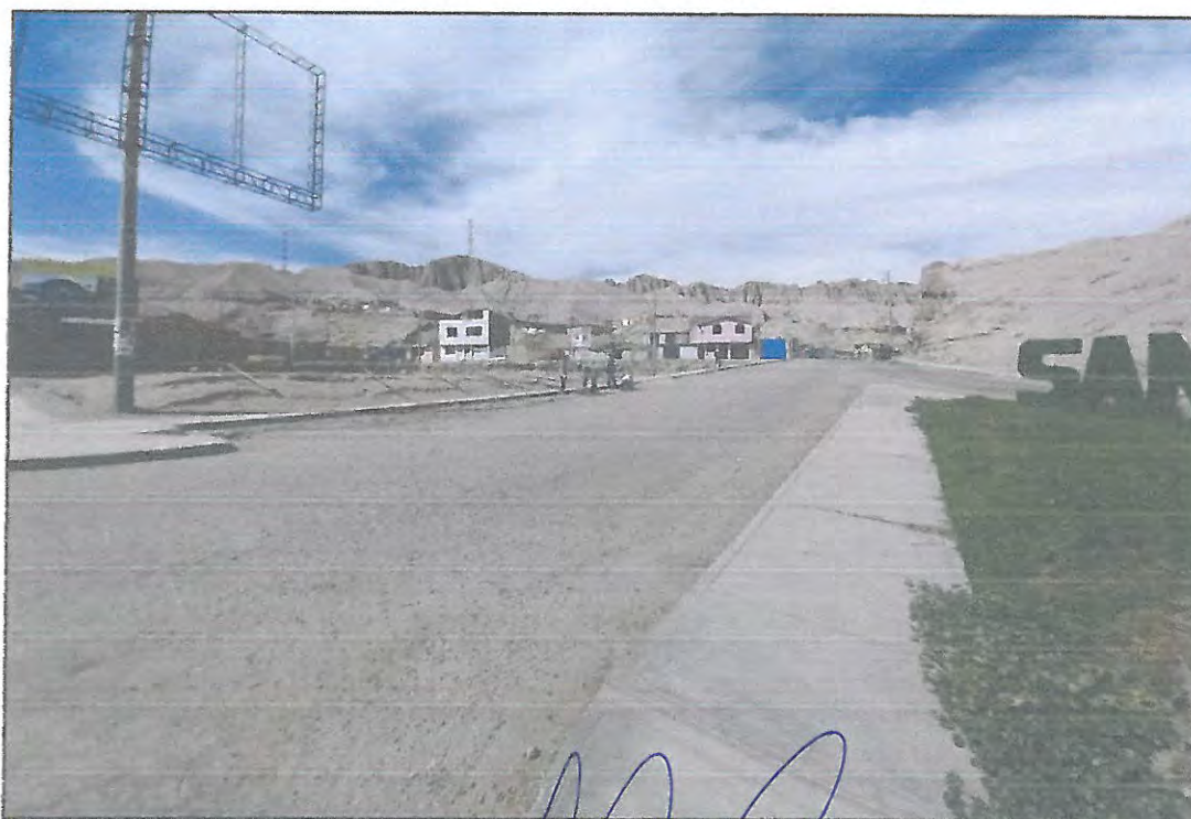
Foto 22. Vista de Avenida Perimetral
