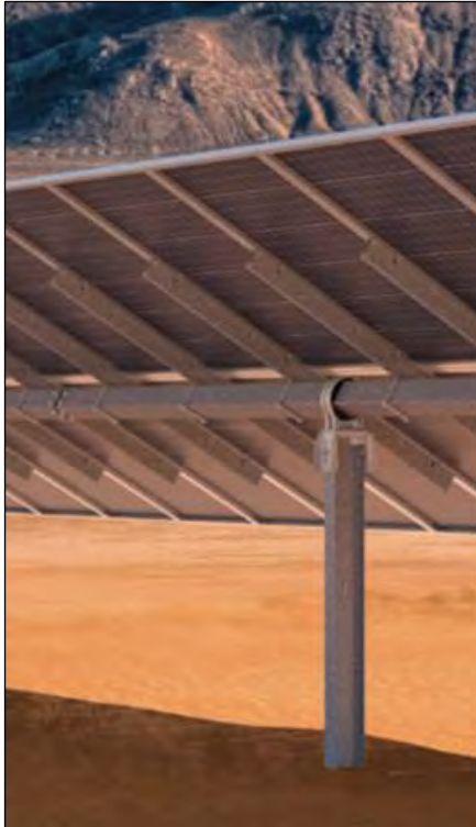
Figura 2.4-3: diseño del soporte para los módulos fotovoltaicos propuestos
