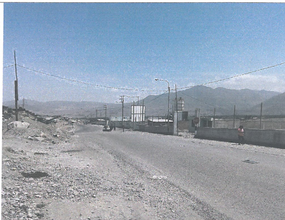
Vista de actividades principales planta concreto
