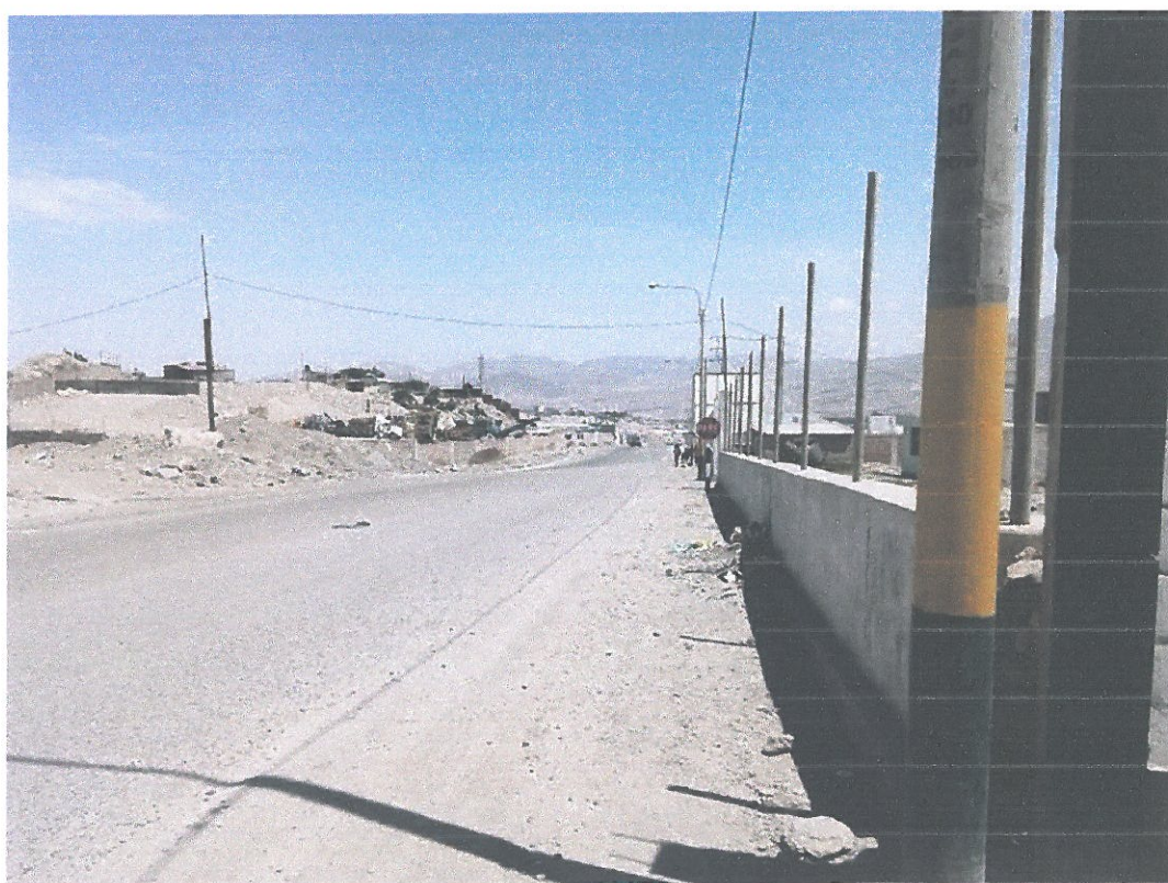
Foto N° 06: INFRAESTRUCTURA VIAL AV. BINACIONAL
