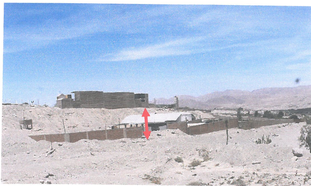
Foto de lado derecho de qbda de cementerio se ve diferencia de altura 13 metros en relación a la parte baja de la quebrada
