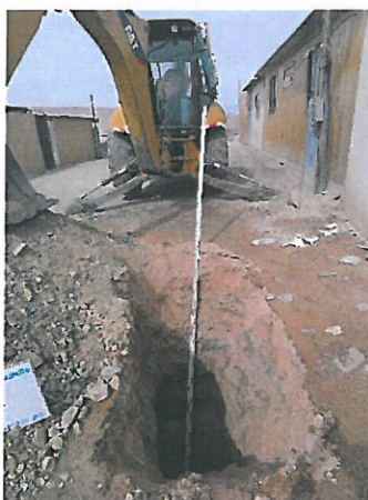
Figura N° 2.- Fotografía de excavación de la calicata C-01.
