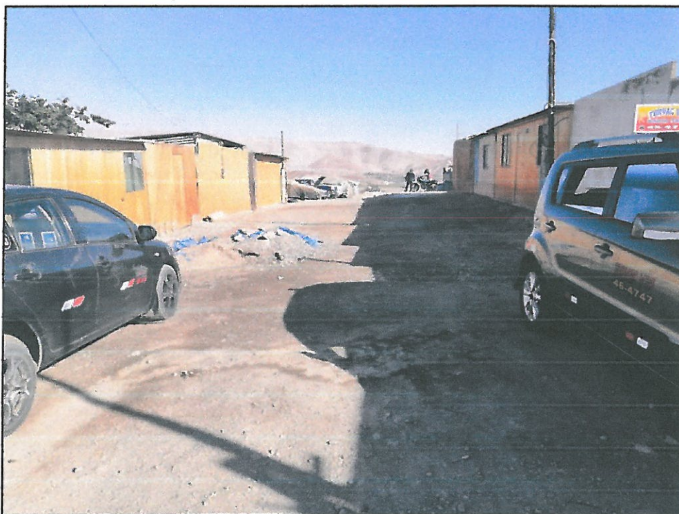
En la Fotografía 01 se observa la calle afirmada Los Damascos
