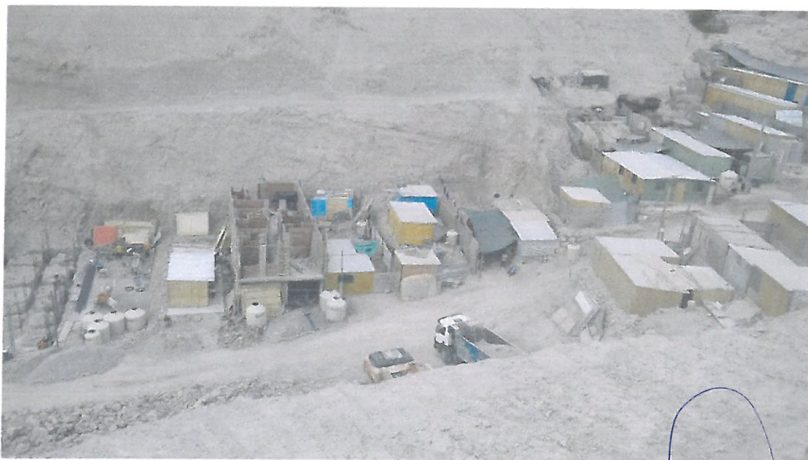
FOTO: SECTOR A6-4A, vista de la zona evaluada, correspondiente a la manzana E y F de los cuales se determinó con niveles de riesgo medio a la parte baja y alto para los lotes ubicados junto al talud.
