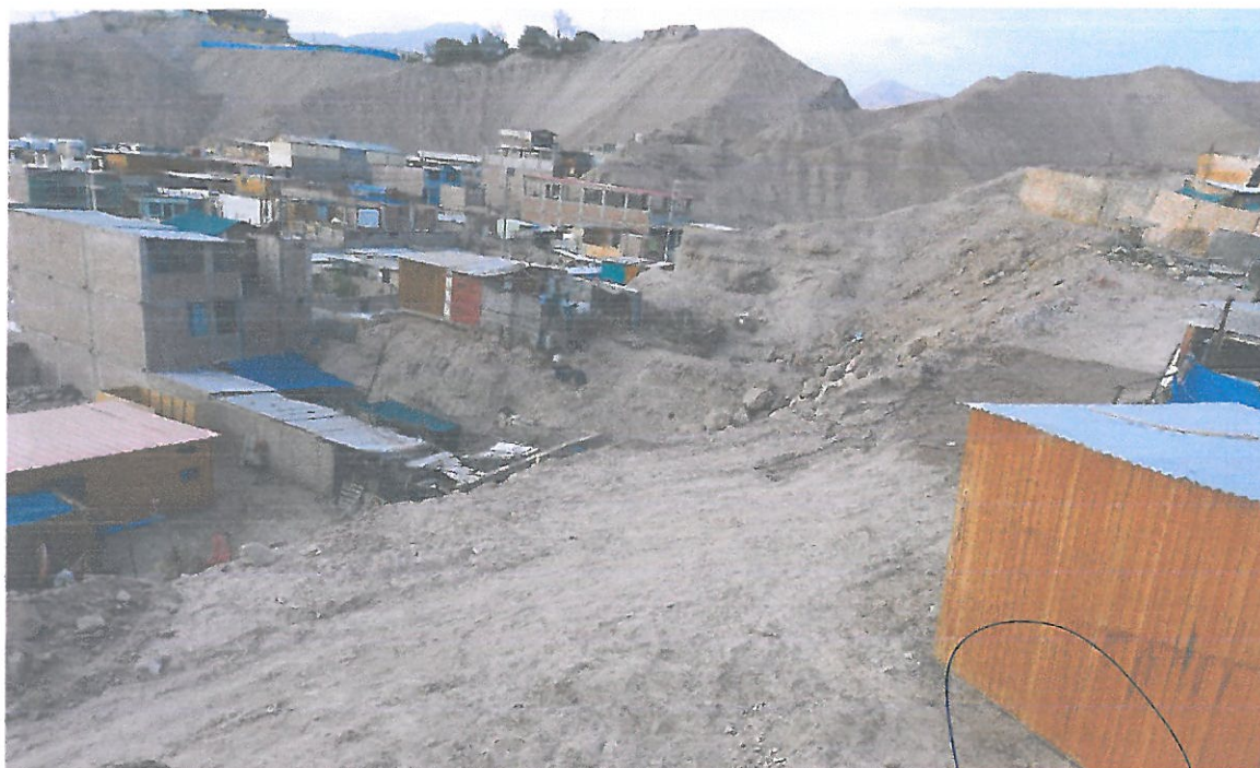
FOTO: SECTOR A6-4A, vista de la zona evaluada.
