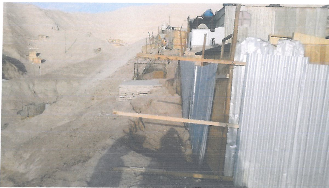
FOTO: SECTOR A6-4A, vista de viviendas alineadas previo replanteo del equipo topográfico.
