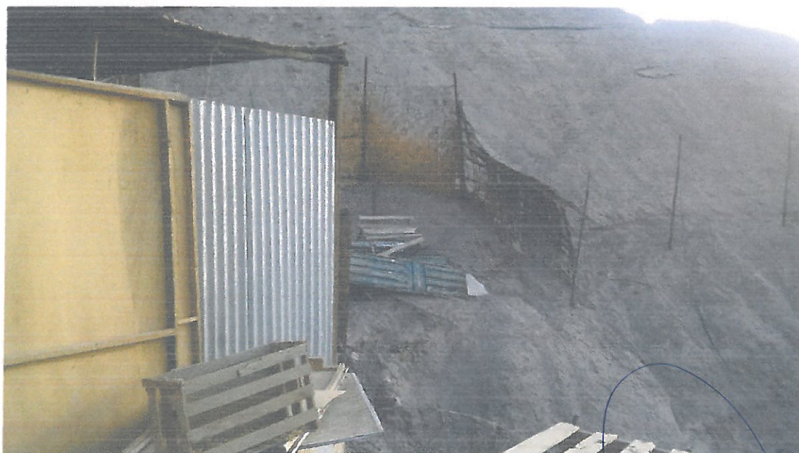
FOTO: SECTOR A6-4A, vista de la zona evaluada, correspondiente al lote 22 de la manzana "A" con nivel de riesgo alto.
