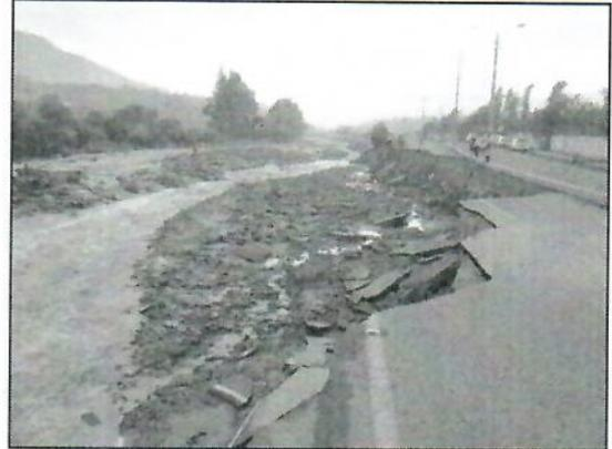
Fotografías 01 y 02: Se ha erosionado el pie del talud ocasionando la pérdida de la plataforma de la vía por incremento del caudal del río.
