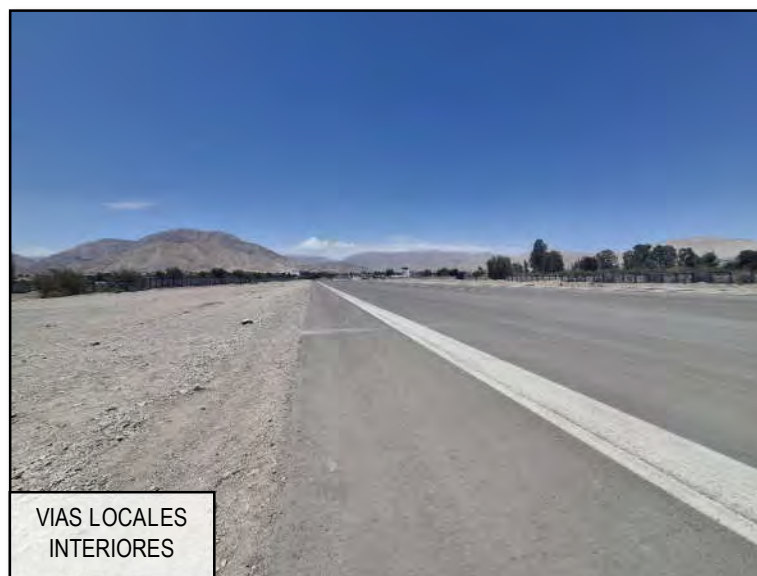
Foto 8. Vías Interiores dentro de la infraestructura del Aeródromo
