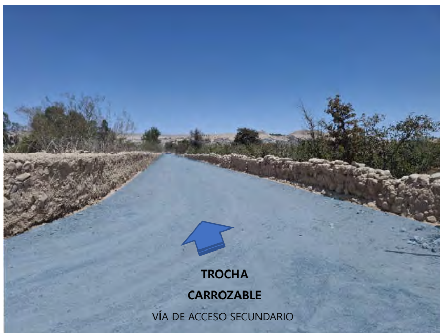
FOTO 3: VISTA DE LA VÍA DE ACCESO 2, POR TROCHA CARROZABLE COLINDANTE AL CERCO PERIMÉTRICO, PARALELO A LA PISTA DE ATERRIZAJE DEL AERÓDROMO.
