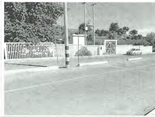
Estación de Bombeo El Totoral
