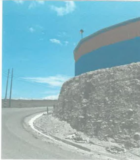
**FOTO 01.** – Vista del talud en la zona este de la sub parcela A, sin medidas de mitigación de riesgo y con una infraestructura en la zona superior.
