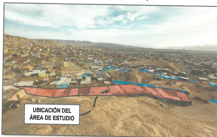
Foto 2. Vista del área de intervención y entorno
