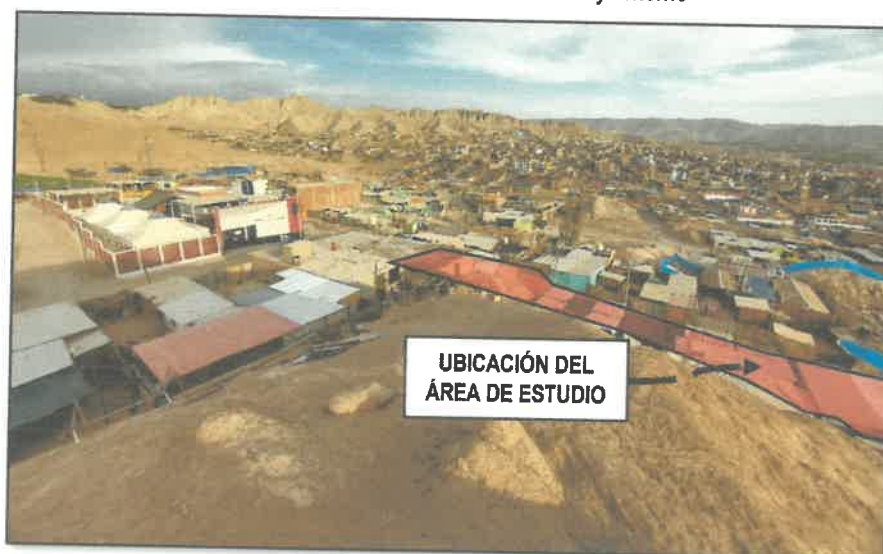
Foto 1. Vista del área de intervención y entorno
