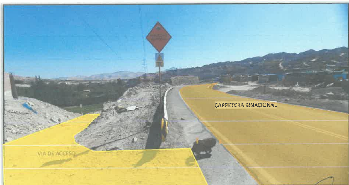
FOTO 12: Vista de la vía de acceso en la zona de estudio y de la Carretera Binacional.
