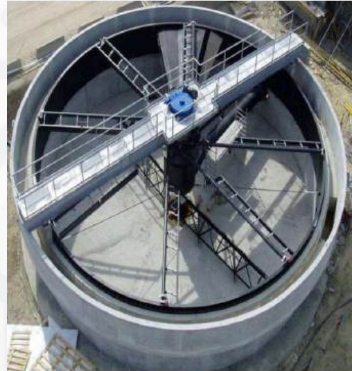
Fig. Espesador por flotación.
