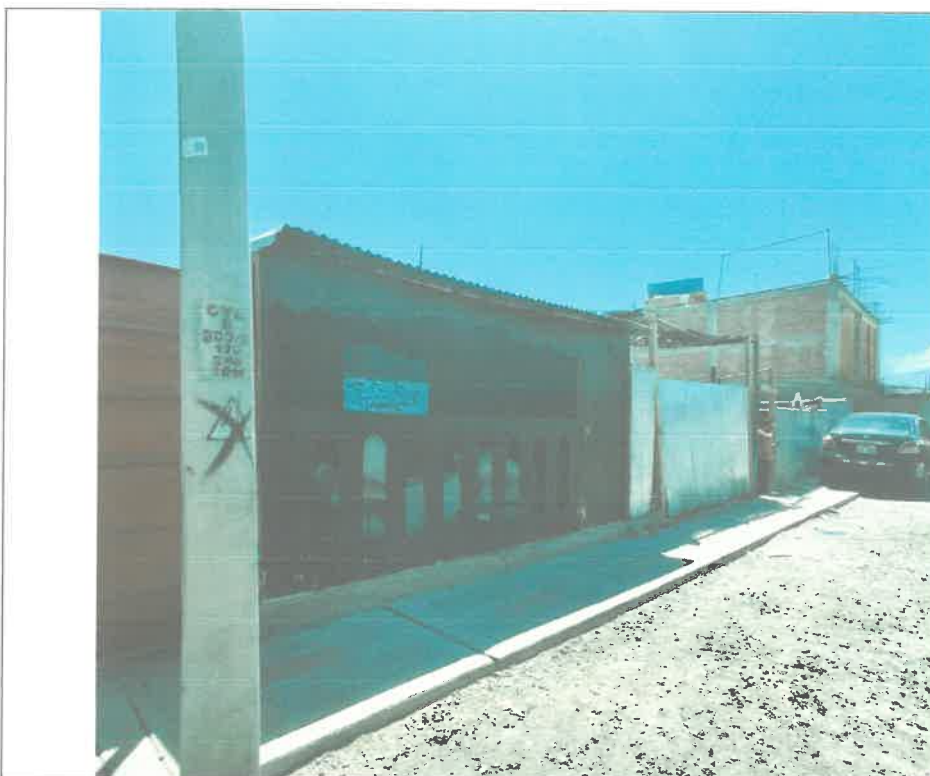
FOTO 01. – Vista de las viviendas ubicadas en la Mz H Lote 6, lo cuales cuentan con pistas, veredas y redes de energía eléctrica.
