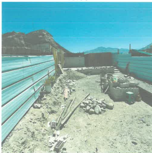
Vista del interior de las viviendas con cercos perimétricos y módulo de madera
