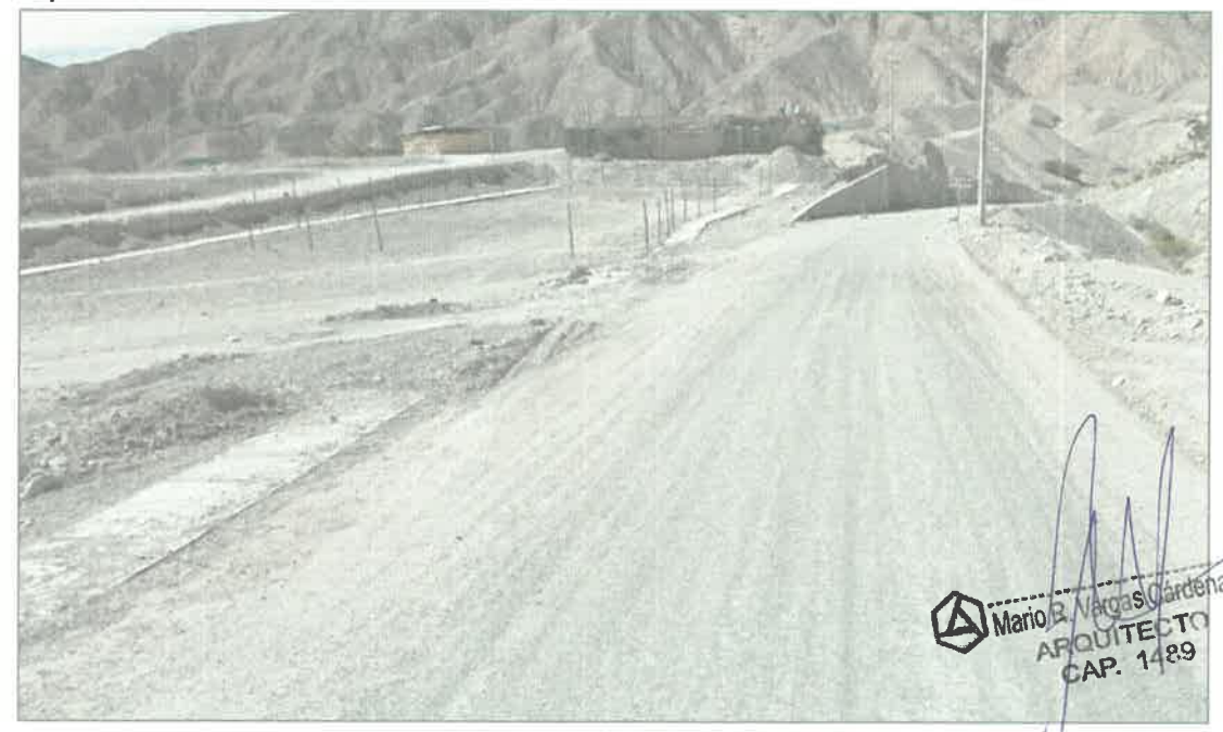
FOTO 12: La Vía Nacional sigue por la derecha hacia, la zona en estudio se ubica a la izquierda de la vía.
