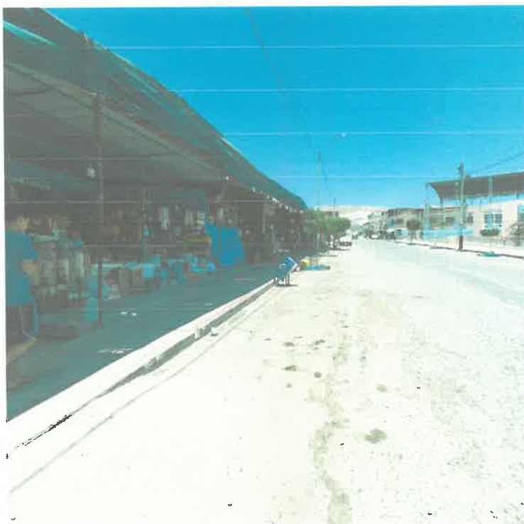
Foto 4: Vista del lado frontal del predio colindante con al Av. San Bernabé.
