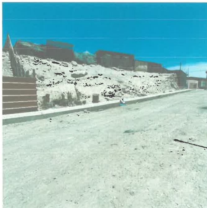
Foto 2: Vista del lado oeste del predio con la presencia de un talud.
