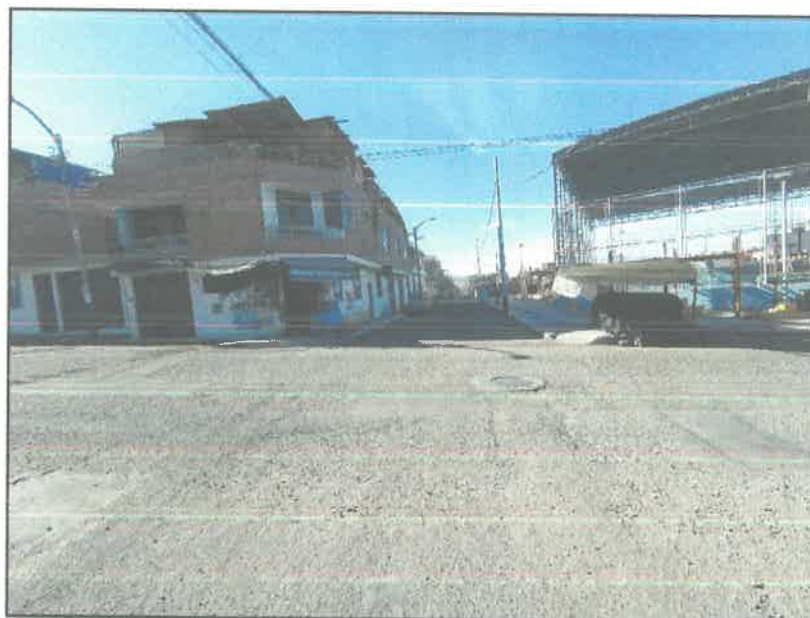
Foto 3. Vista de Calle 34
