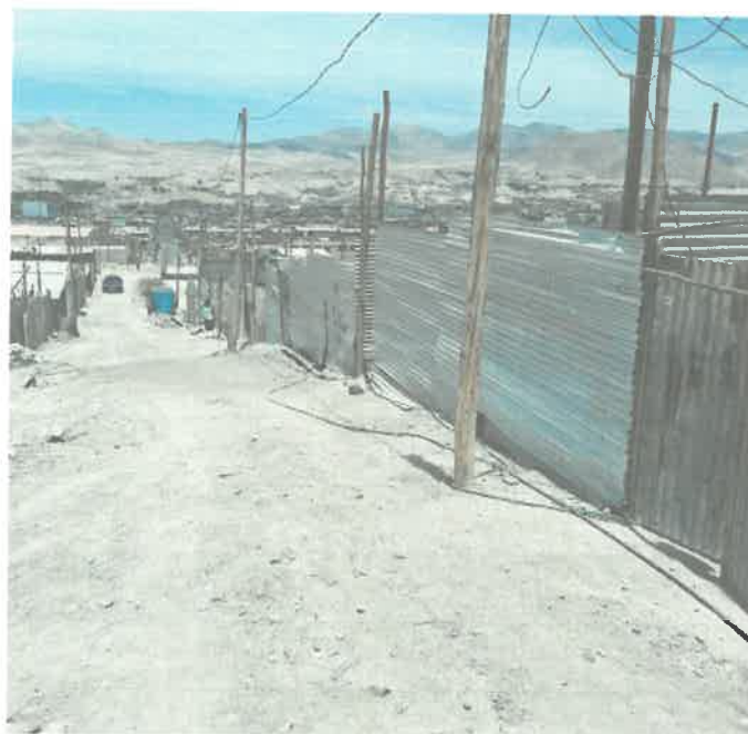
Foto 6: Vista de la Calle 01 a nivel de trocha carrozable y con redes eléctricas con postes de madera.
