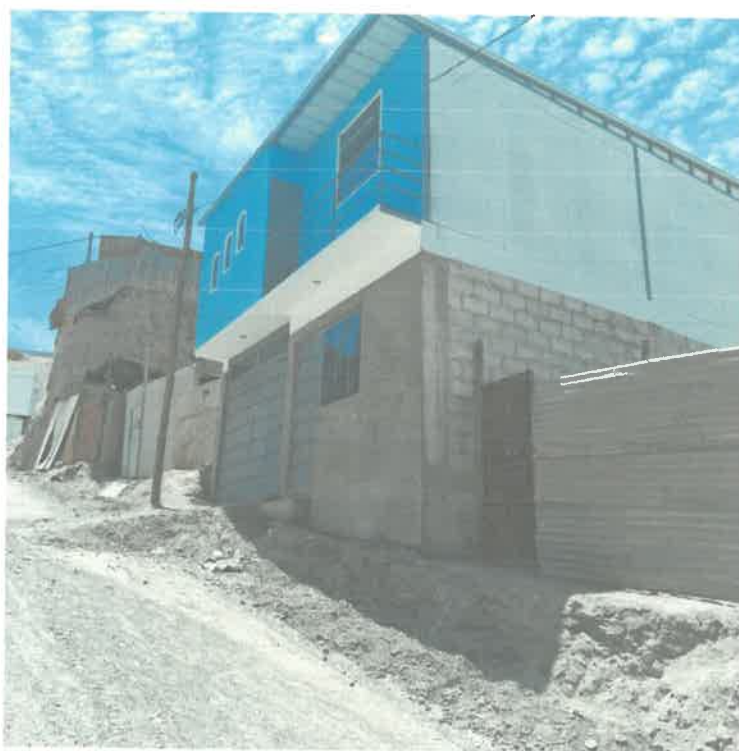
Foto 5: Vista de vivienda de dos niveles con construcción de bloquetas y drywall.
