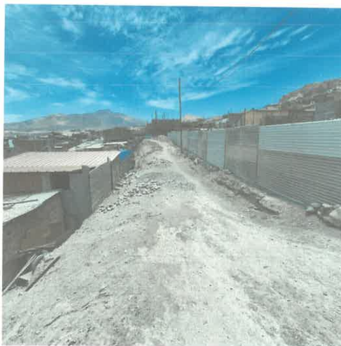
Foto 2: Vista del Pasaje N°03 a nivel de trocha carrozable con presencia de postes de madera.
