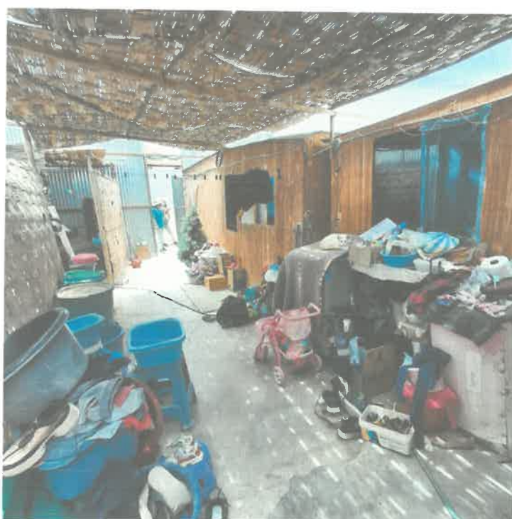
Foto 4: Vista de los interiores de los lotes con módulos de vivienda y piso de concreto.
