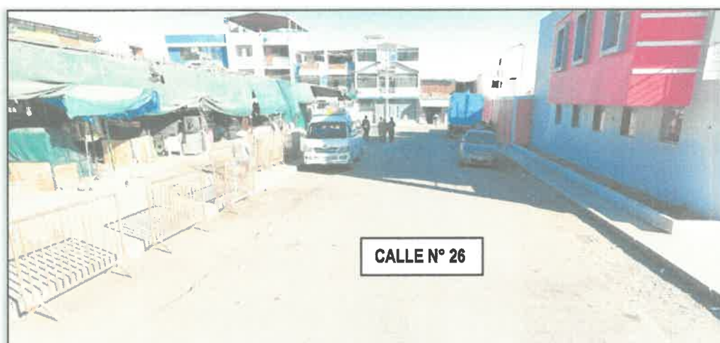
Foto 3. Vista de la Calle N.º 26
