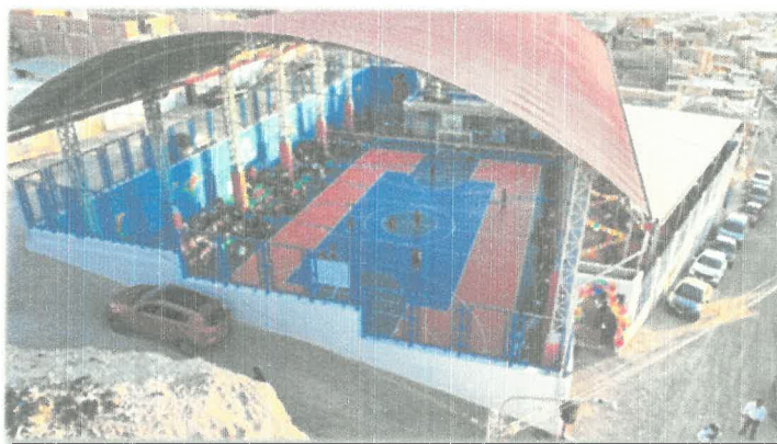
Imagen 3: Vista frontal de la Infraestructura del proyecto "Construcción de muro de contención; en el (la) Av. Andres Avelino Cáceres (tramo calle Moquegua – calle 1 de mayo) distrito de Moquegua, provincia Mariscal Nieto, departamento Moquegua.
