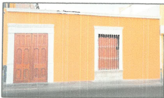
Imagen 1. Inmuebles de la Calle Moquegua N° 324 y N°364.
