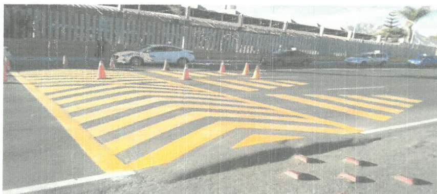
Imagen 1: Mantenimiento de vías
