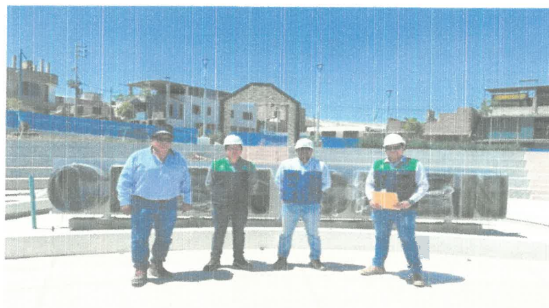
Imagen 3: Visita a la obra de la Plaza Cívica Chen Chen
