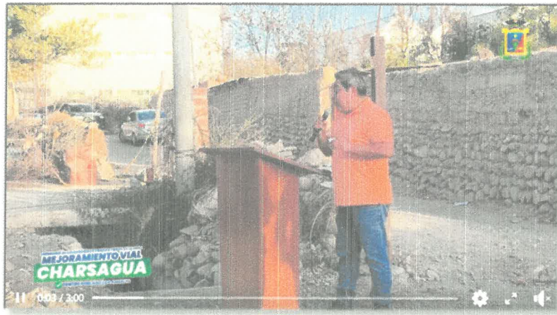
Imagen 12: Obra de Mejoramiento Vial Charsagua
