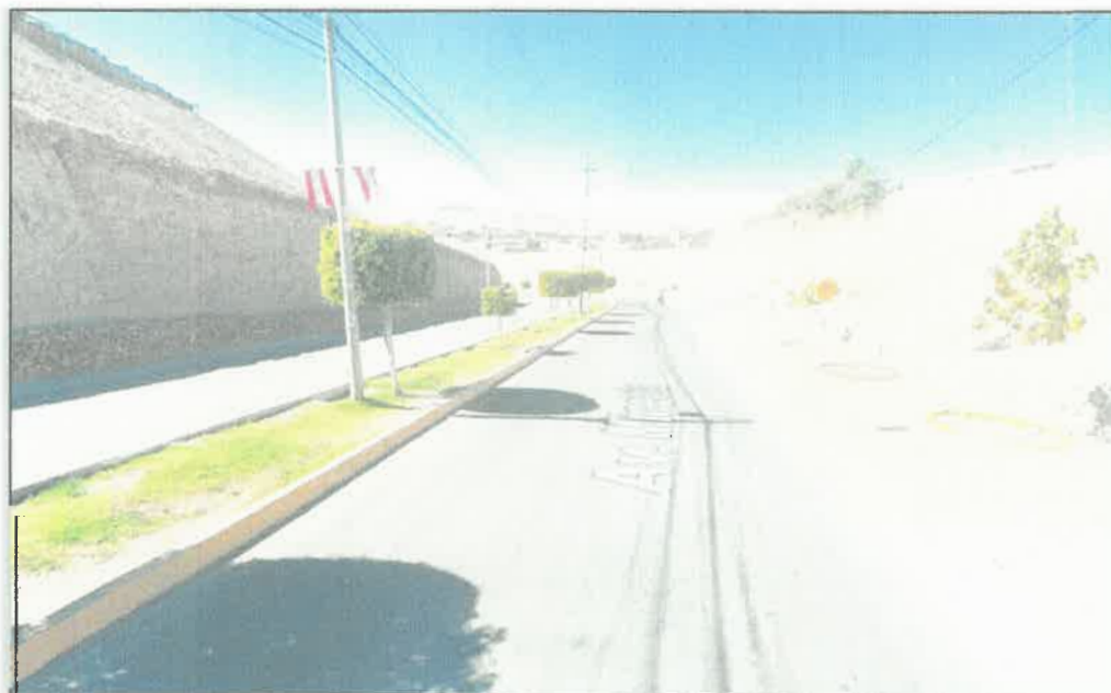
Foto 6. Vistas de la Avenida Minería
