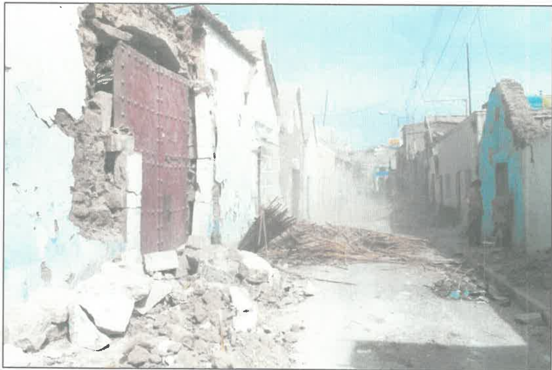
Imagen terremoto año 2001 en la ciudad de Moquegua
