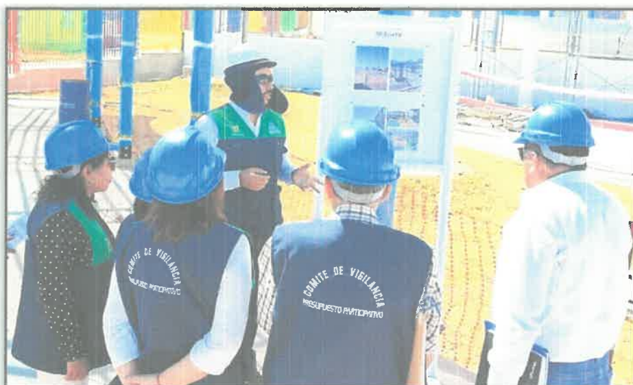
Integrantes del Comité de Vigilancia 2026-2028, realizando visitas a las diferentes obras.
