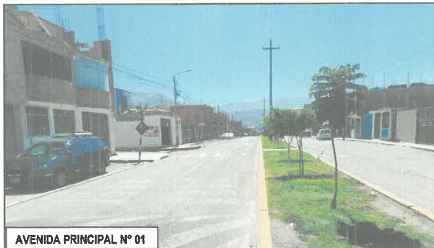
Foto 3. Vista de las calles de acceso
