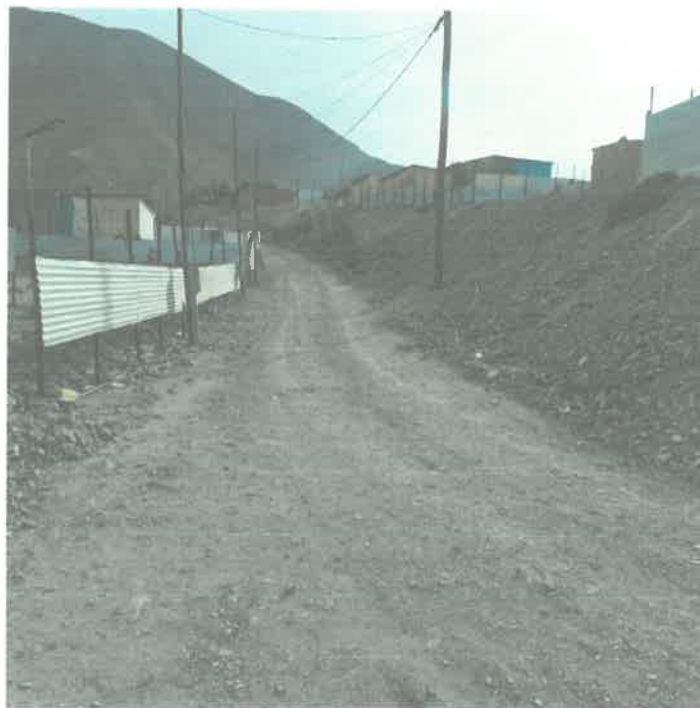
Foto 8: Vista de la Calle 03 a nivel de trocha carrozable, a la derecha la Mz C y a la izquierda la Mz E.
