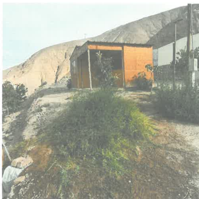
Foto 2: Vista de los módulos de vivienda de madera y cobertura de calamina en los predios de la Asociación.
