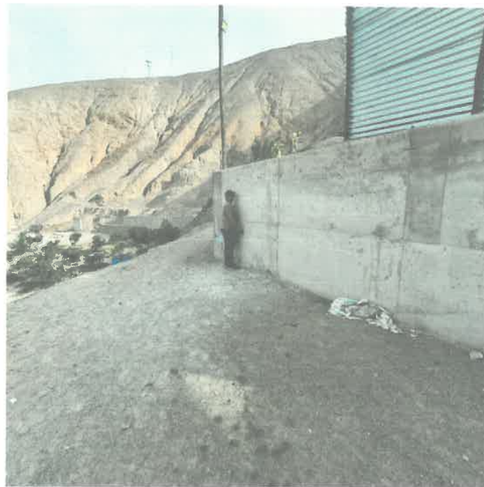
Foto 6: Vista de muros de contención implementados en la asociación
