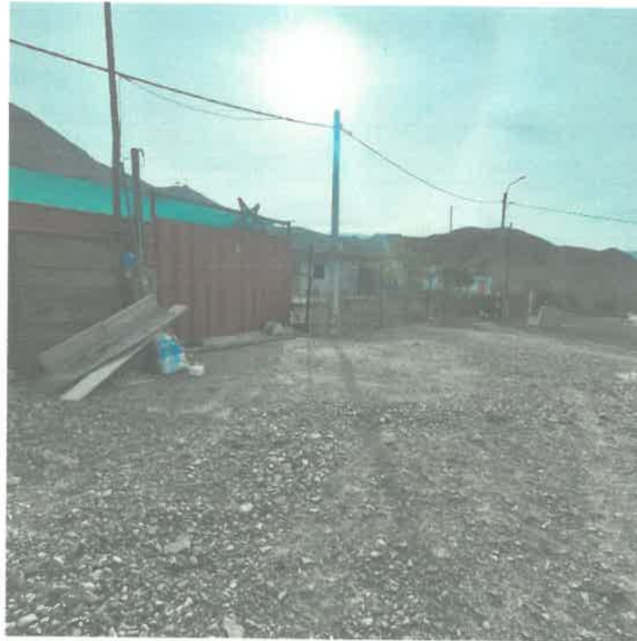
Foto 5: Vista de las redes eléctricas para el suministro eléctrico de la Asociación.
