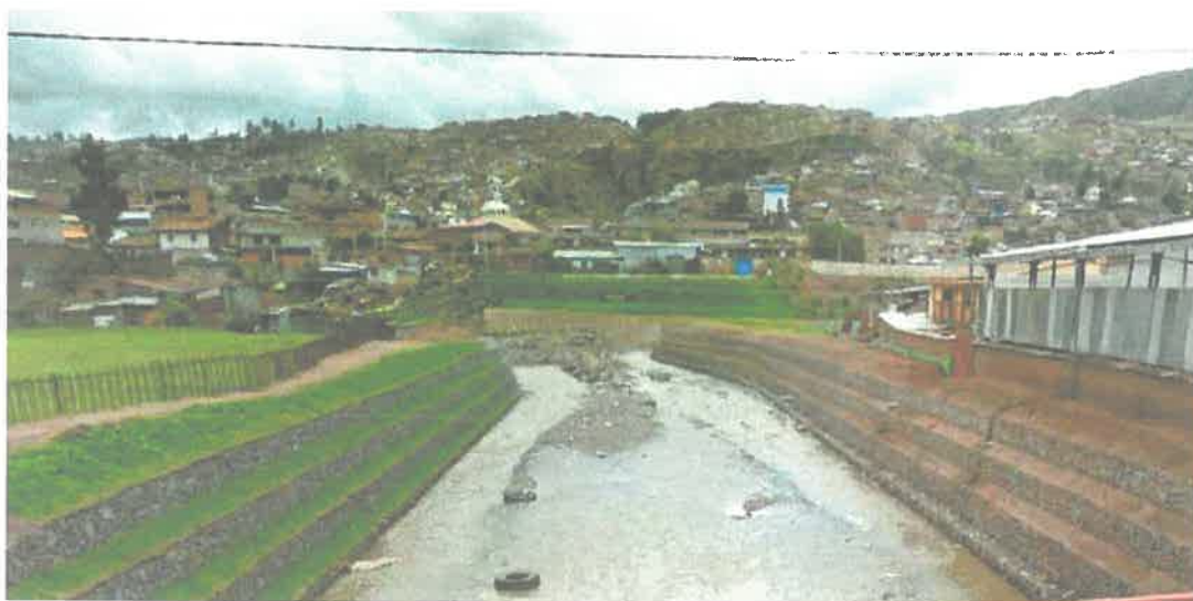
Ilustración 21. Muros de gaviones – imagen referencial
