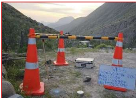
Estación de Vibraciones
