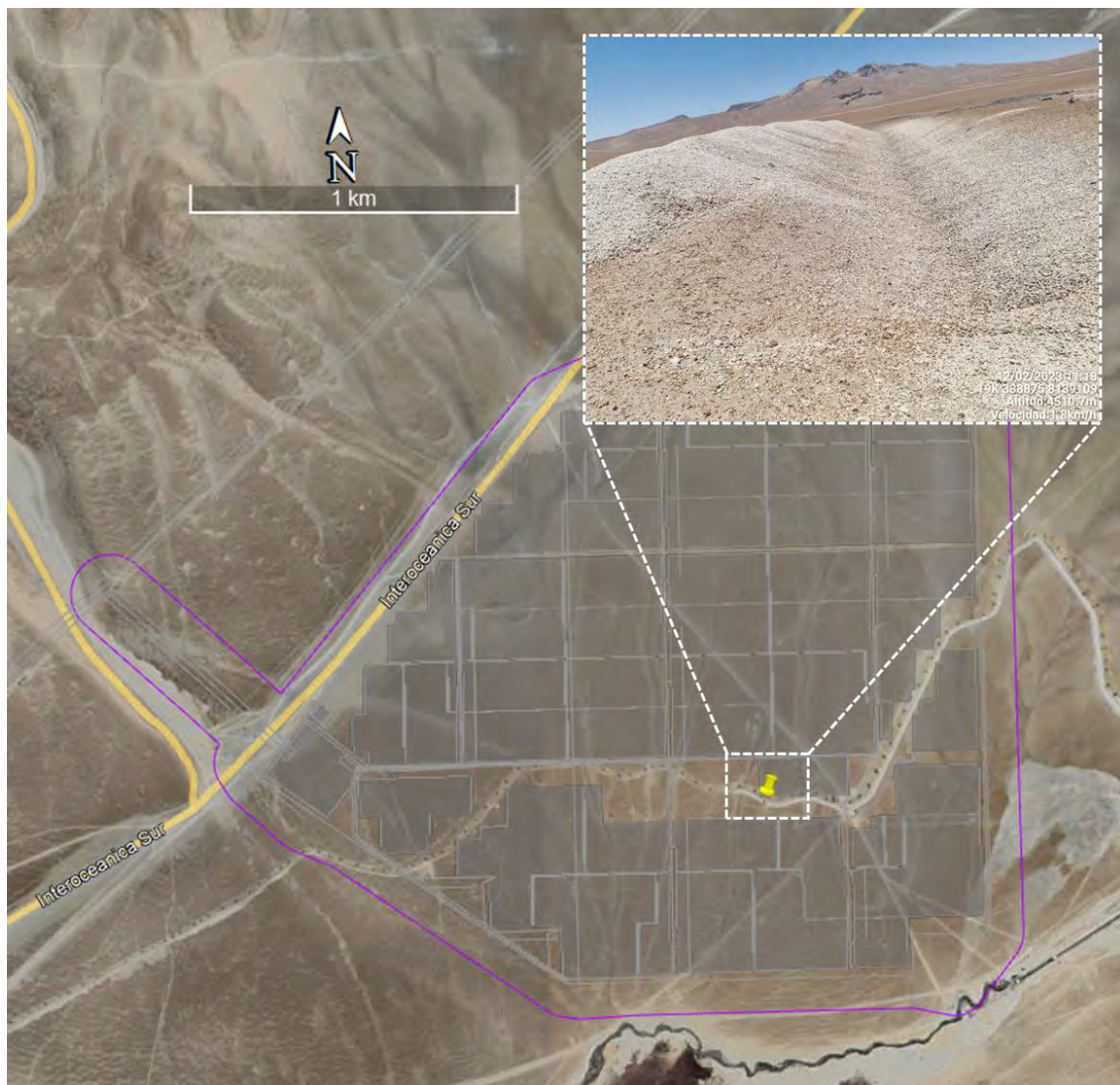
Figura 7 Situación actual del canal Pasto Grande
