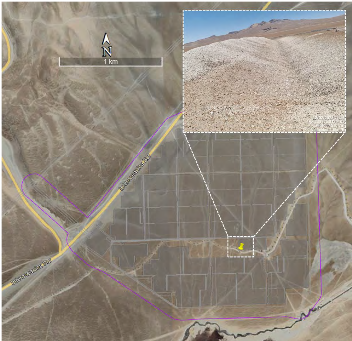
Figura 4 Situación actual del canal Pasto Grande
