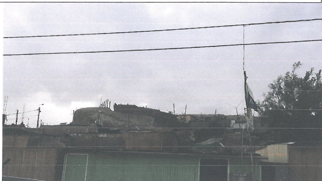
Vista de la asociación desde el sur zona de riesgo
