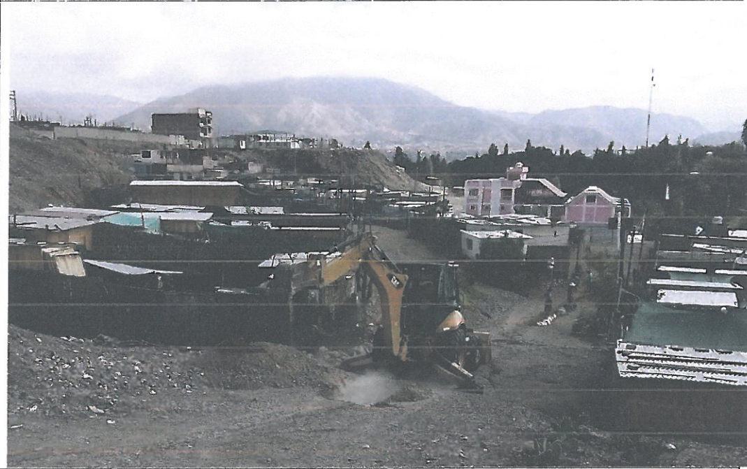
Vista de ejecución de calicatas
