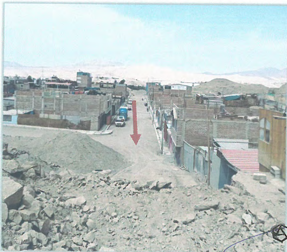
FOTO 03: Vista del Sector 2B, calle de acceso principal a Manzana F
