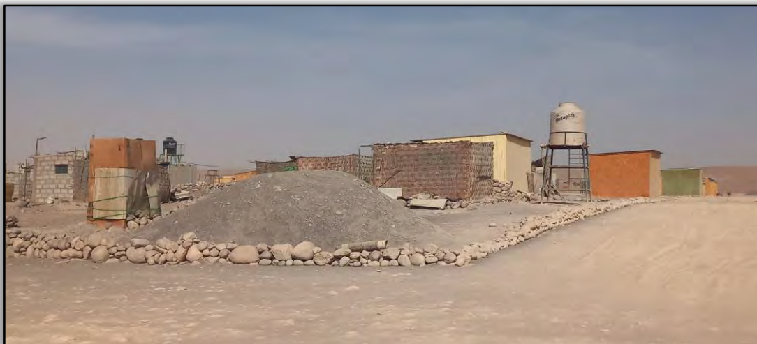
FOTO 10: Edificaciones rusticas y reservorios agua en la Asociación Irrigación Clemesí – Moquegua
