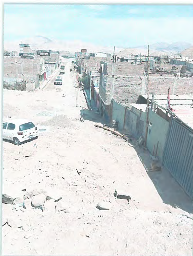
FOTO 11: Viviendas precarias en posesión del lote 15 manzana F sector 2B (derecha). AL centro se aprecia la calle San Diego, vista este oeste, antes de la colocación de carpeta asfáltica.
