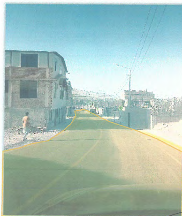
FOTO 15: Vista otro ingreso desde vía secundaria denominada Av. Daniel Becerra Ocampo.
