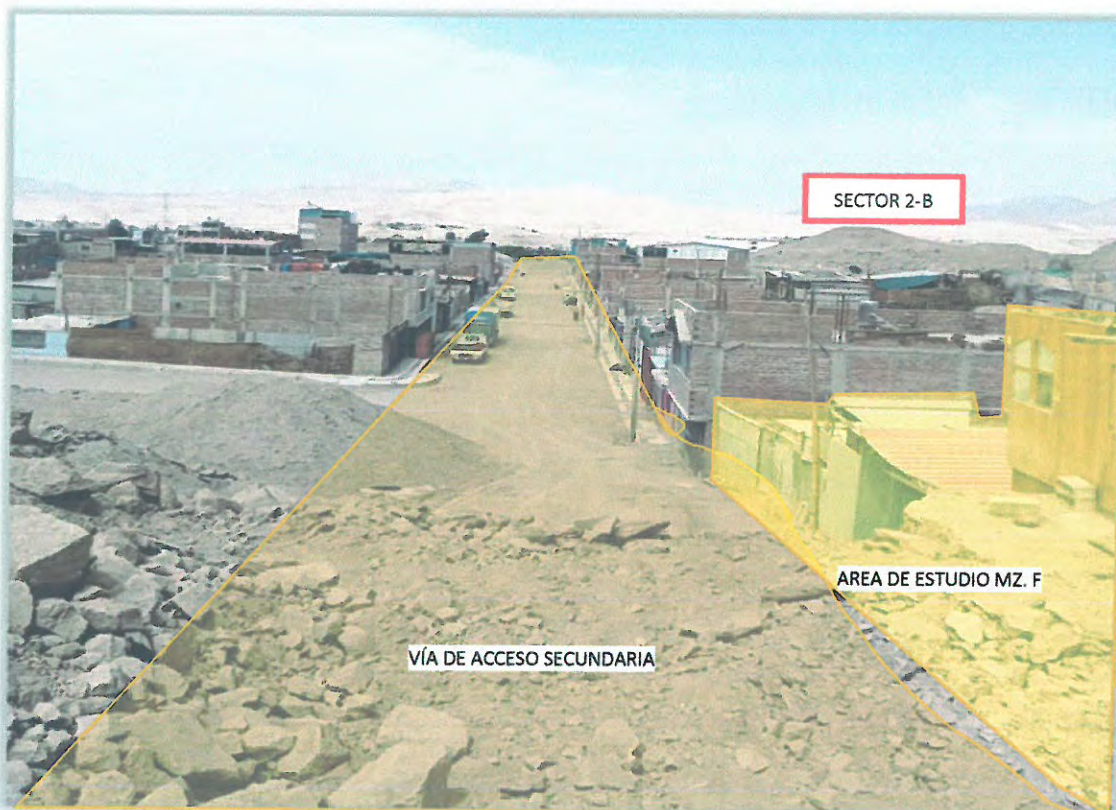
FOTO 14: Vista hacia el sur de la Vía de acceso principal a la zona de trabajo (Vía secundaria) denominada calle San Diego
