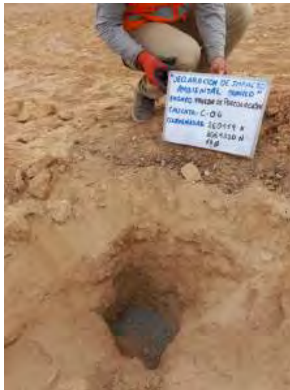
Foto 16. Colocación de la capa de grava para el inicio del test de percolación en la calicata N.º 06
