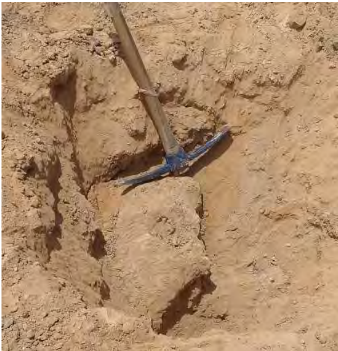
Foto 1. Excavación de la calicata N°01 para el test de percolación.
