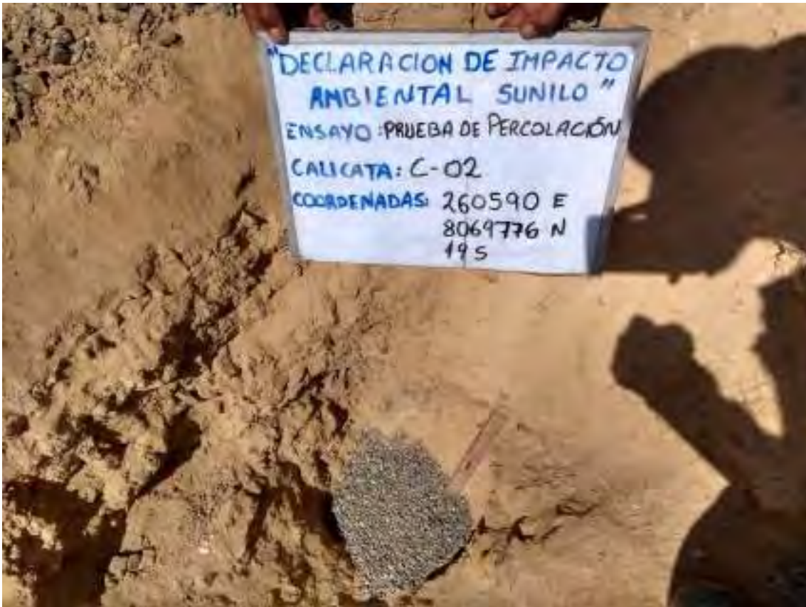
Foto 4. Colocación de la capa de grava para el inicio del test de percolación en la calicata N.º 02
