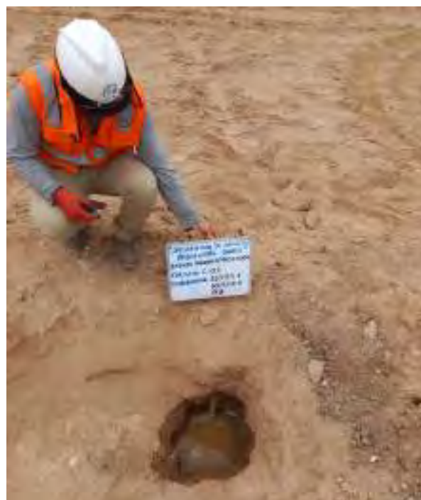
Foto 17. Saturación del agujero antes de iniciar la medición de descenso del nivel de agua en la calicata N.º 06
