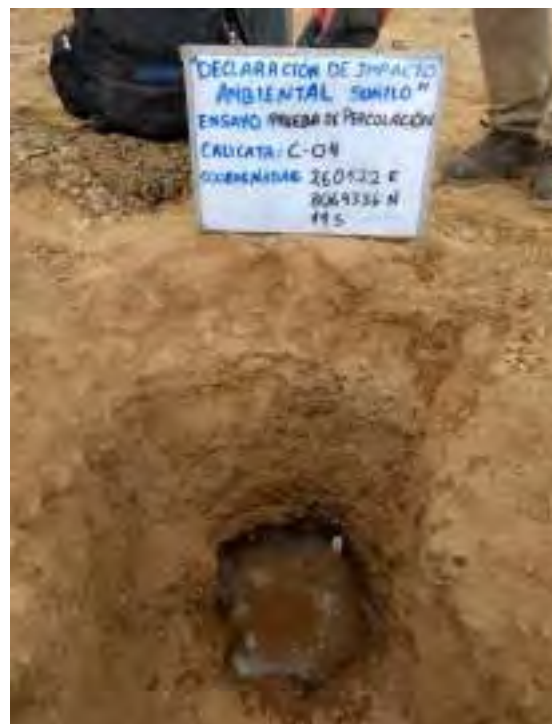
Foto 11. Saturación del agujero antes de iniciar la medición de descenso del nivel de agua en la calicata N.º 04
