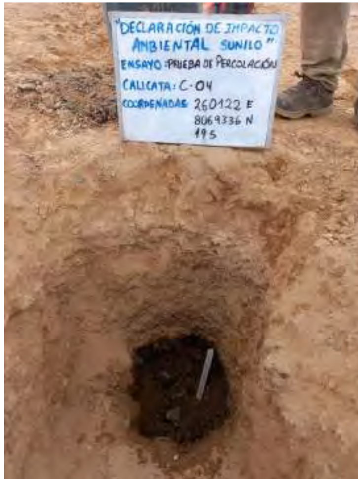
Foto 12. Medición del descenso de agua en la calicata N.º 04
