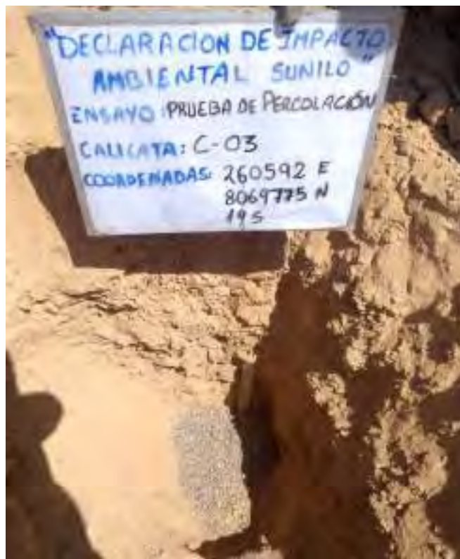
Foto 7. Colocación de la capa de grava para el inicio del test de percolación en la calicata N.º 03
