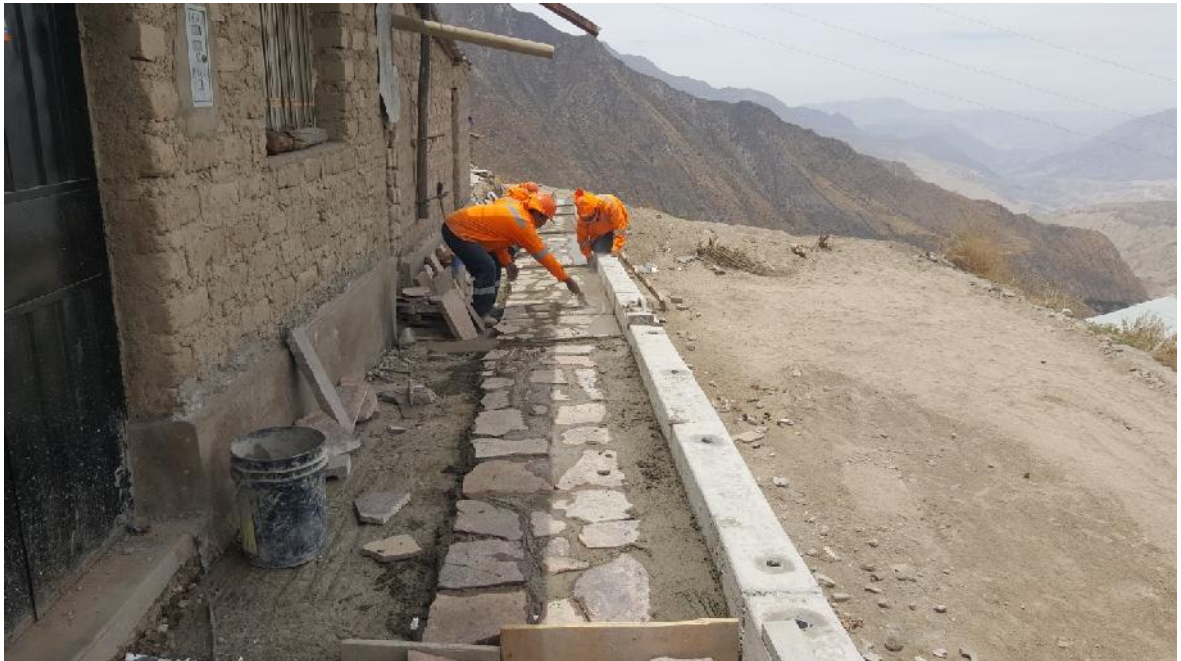
Foto N° 03 Proceso de enchapado de piedra
