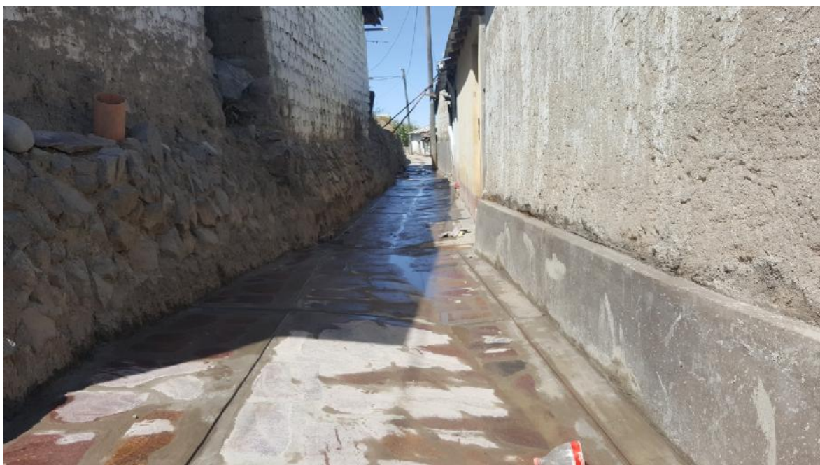
Foto N° 01 Caminerias de acceso peatonal
