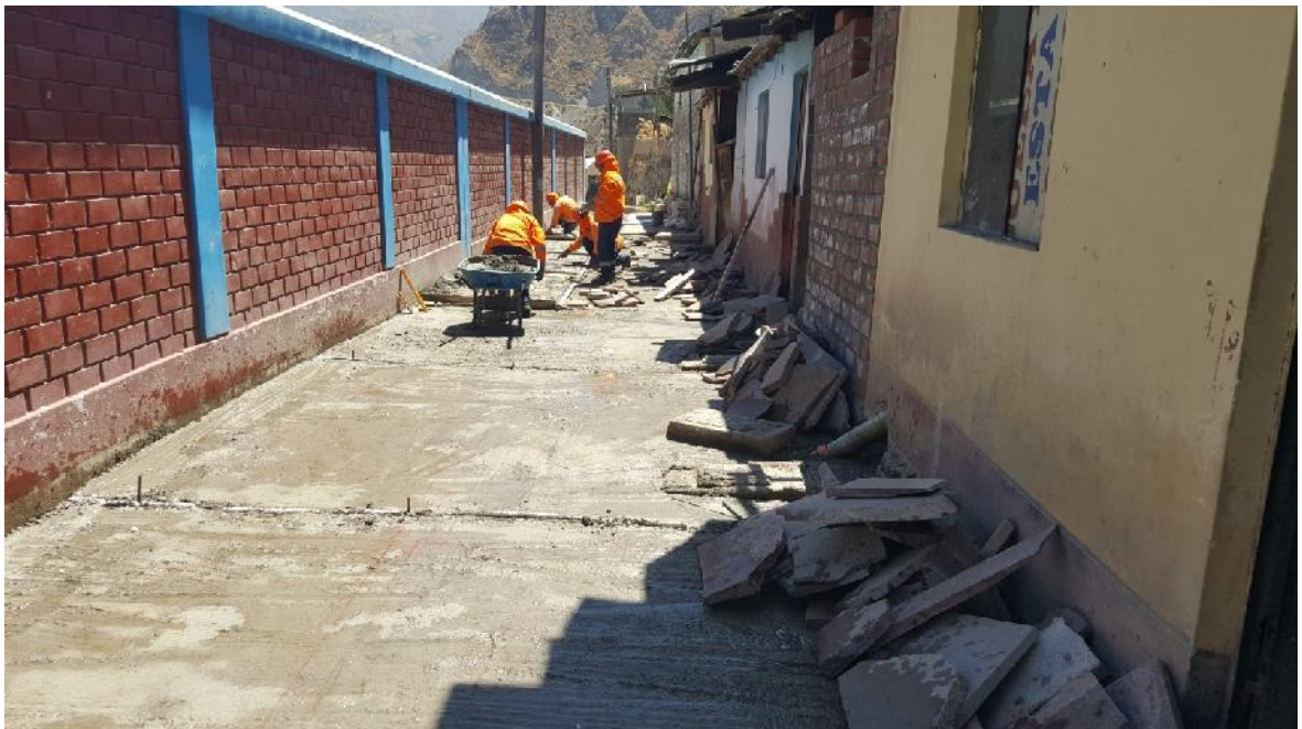
Foto N° 05 Proceso de enchapado de piedra laja.
