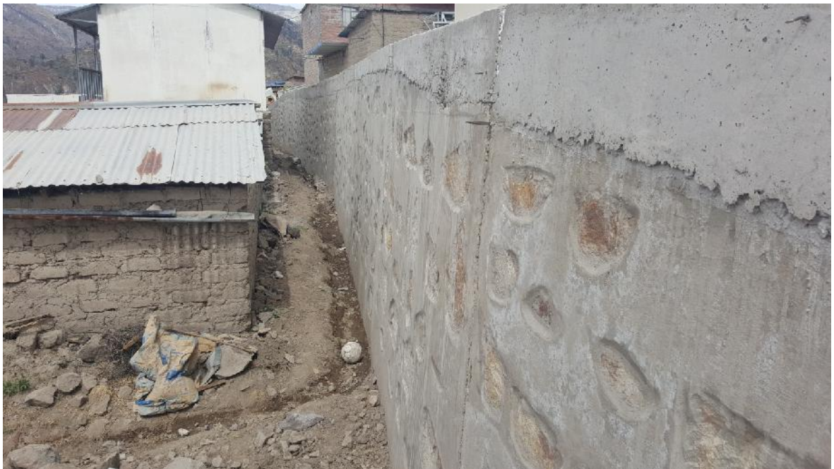
Foto N° 04 Muro de Contención.
