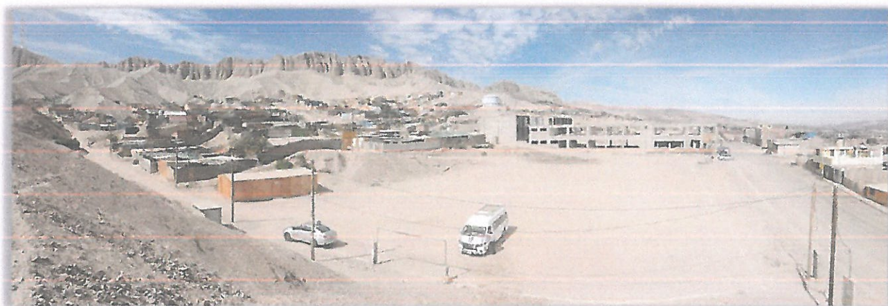
FOTO10: Vista panorámica hacia el sur este del Sector A-11
