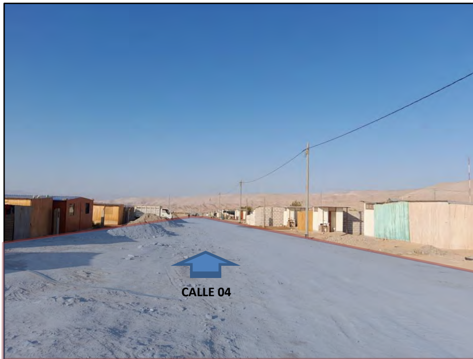
FOTO 4: Vista de la vía de acceso denominada Calle N°04, vía local primaria del área de intervención.
