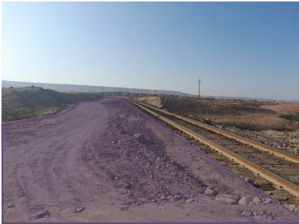
FOTO 7: Vía de acceso al C.P. Nuevo Querapi al costado de la línea férrea
