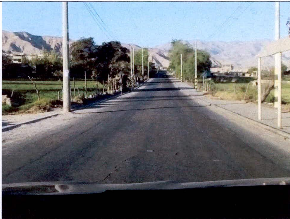
Vista de la carretera Moquegua los Ángeles
