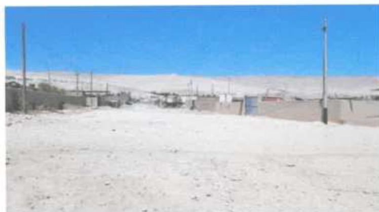
Foto que muestra el tipo de viviendas de la comunidad, de este tipo de viviendas se originan los riesgos de viento y de caída de techos.
