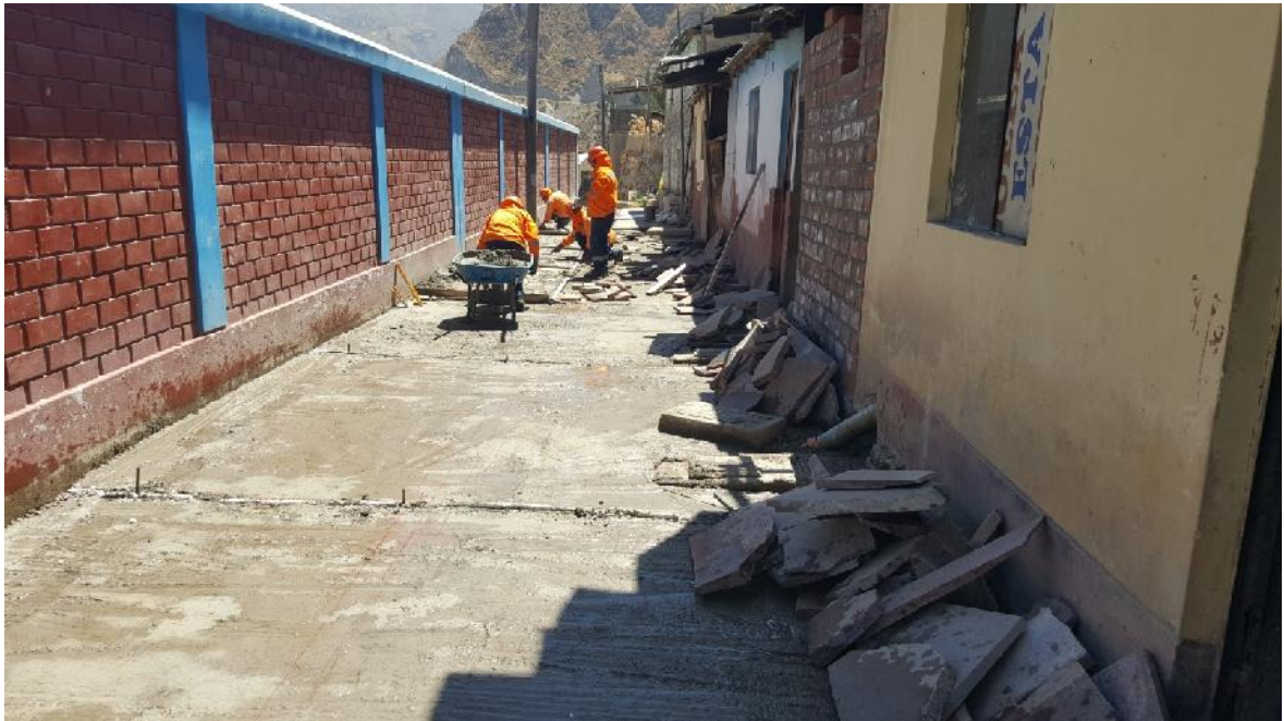
Foto N° 05 Proceso de enchapado de piedra laja.
