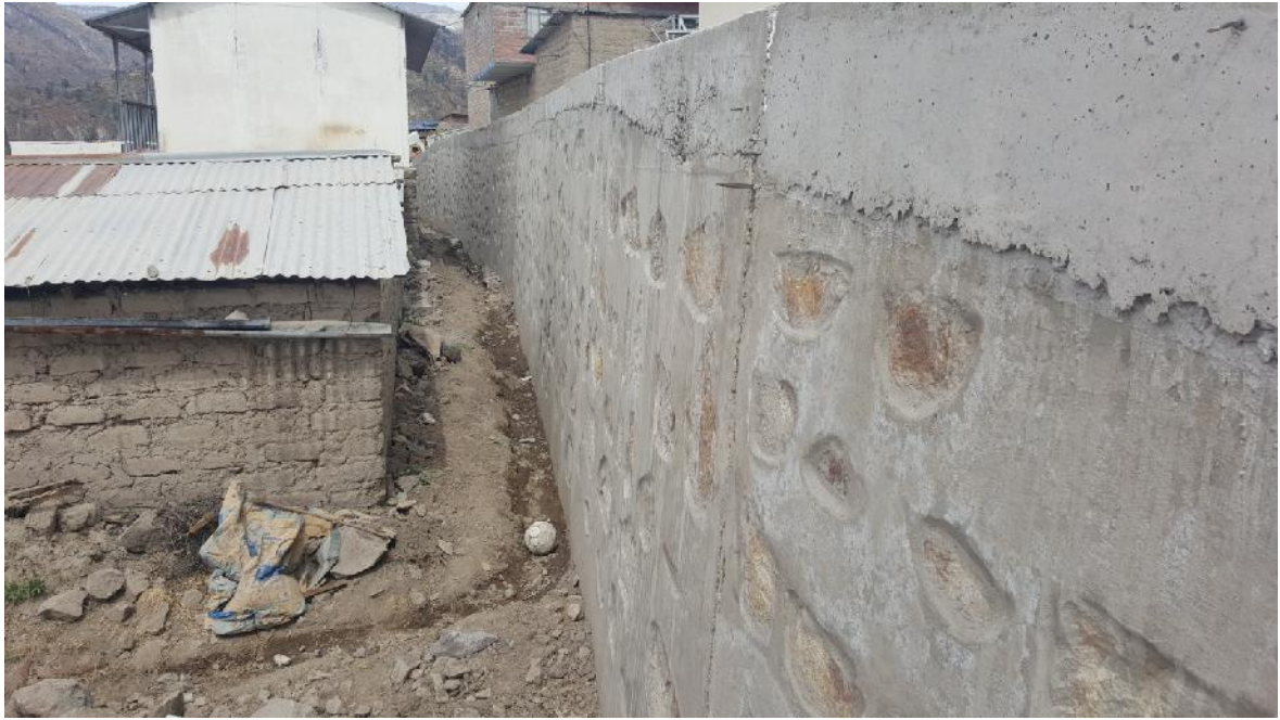
Foto N° 04 Muro de Contención.
