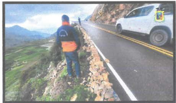
Rehabilitación de vías en la zona de Huachunta
