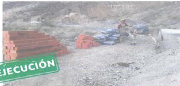
ENTREGA DE MATERIAL A LA AEO PARA LA CONSTRUCCIÓN DE BIODIGESTORES
