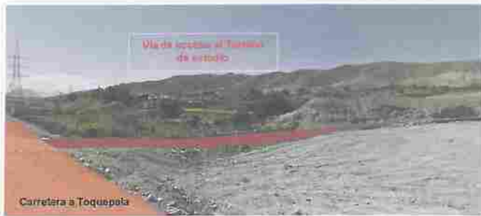
Foto 09: Antigua Carretera a Toquepala (Carretera Binacional)
