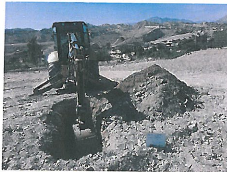
Figura N° 2.- Fotografía de excavación de la calicata C-01.
