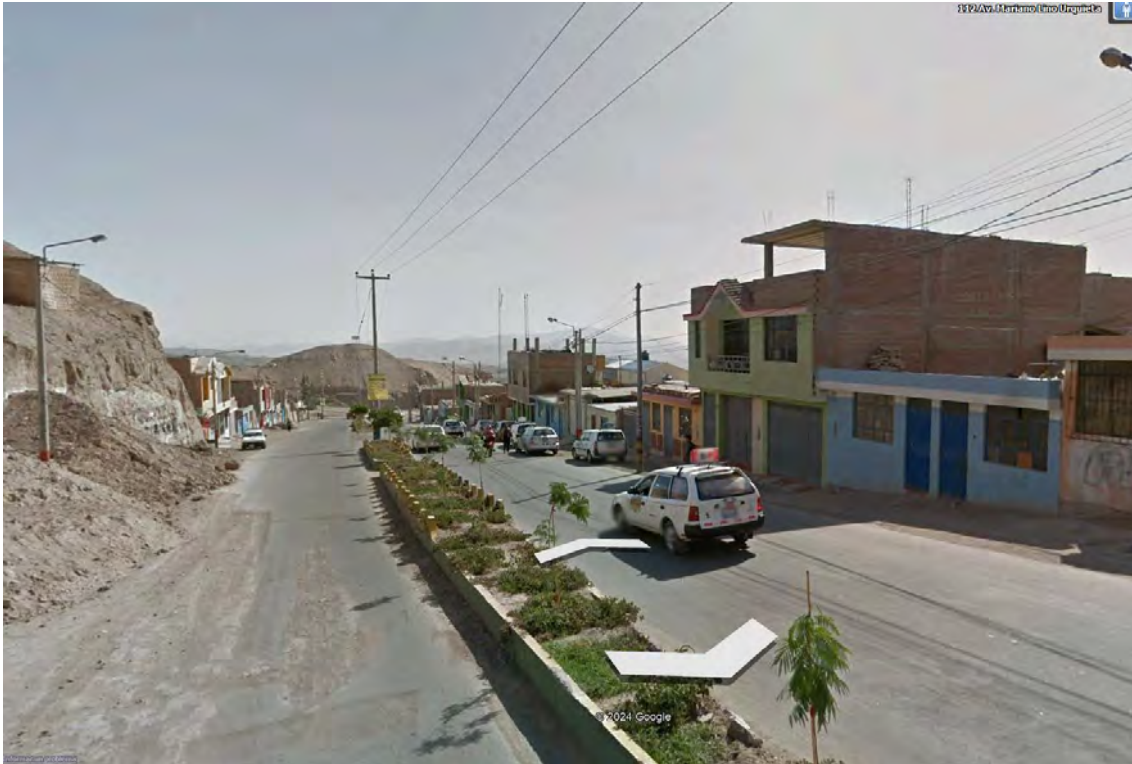
IMAGEN 9: INFRAESTRUCTURA VIAL DE LA AV. MARIANO LINO URQUIETA
