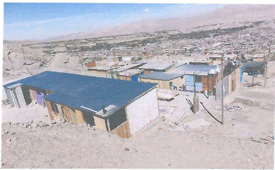
Imagen: se visualiza el posicionamiento de las viviendas después de los trabajos de mitigación.
