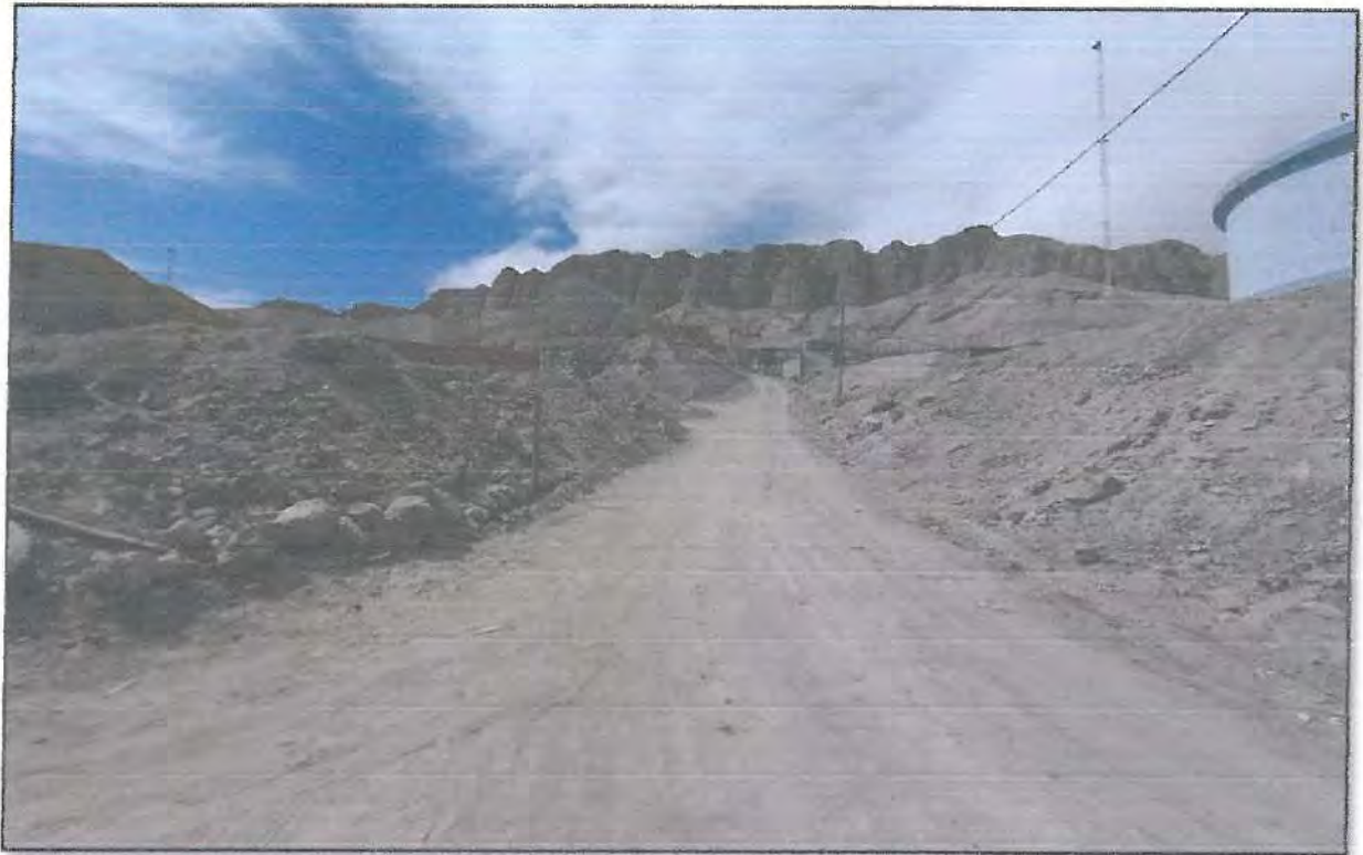
Foto 3. Vista de Calle N° 11 (cerca al reservorio)
