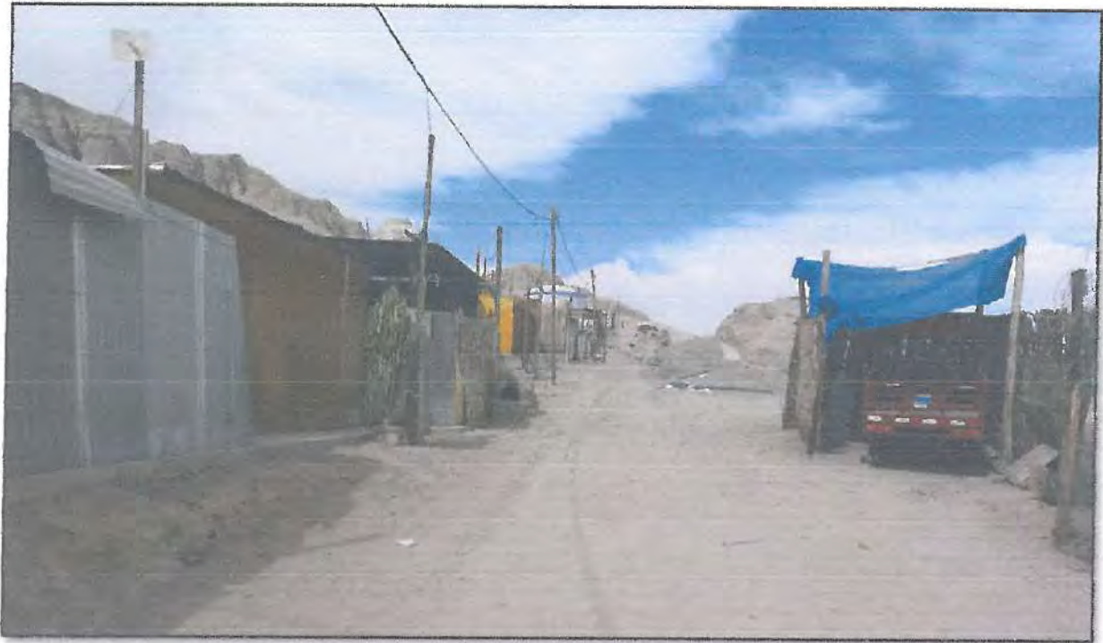
Foto 1. Vista de la Av. Perimetral limite Sector A - 3 y Sector A6 - 4C
