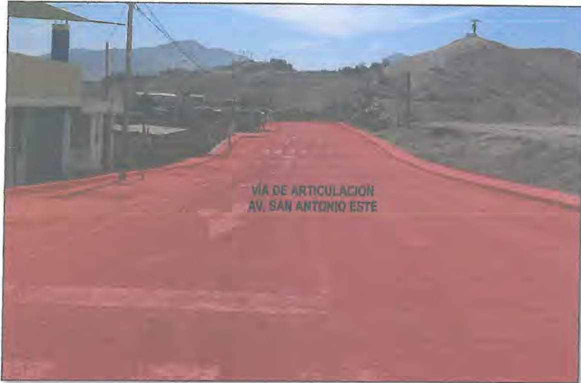
Foto 25. Vía de articulación - Av. San Antonio Este
