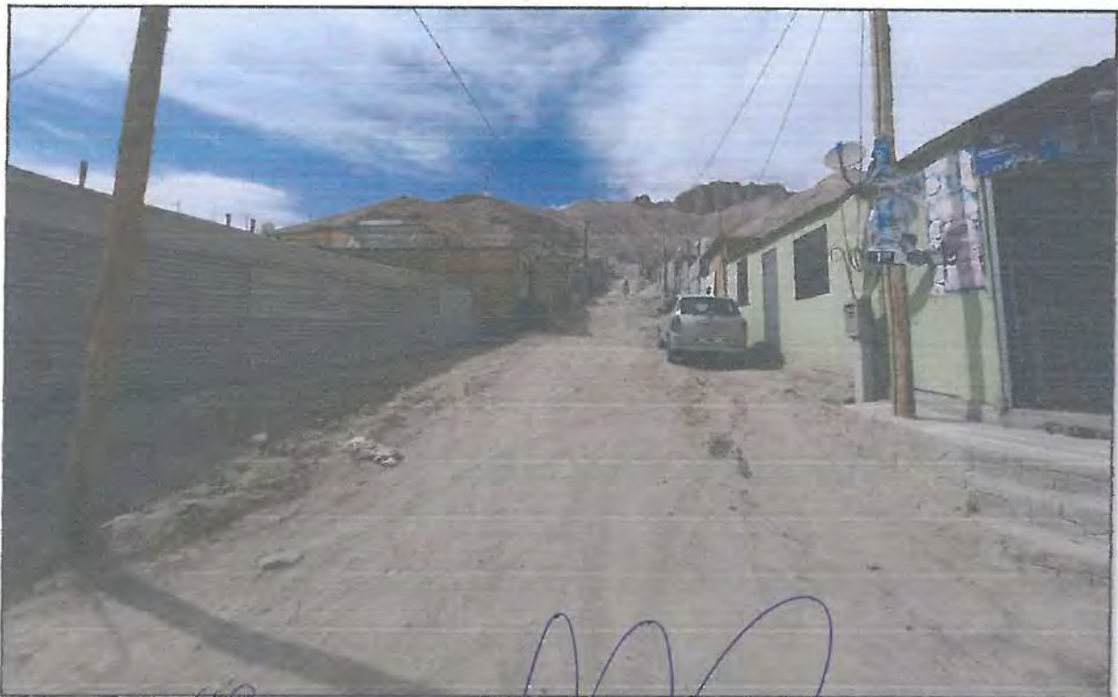
Foto 14. Vista de la Calle N° 07 entre la manzana C y D
