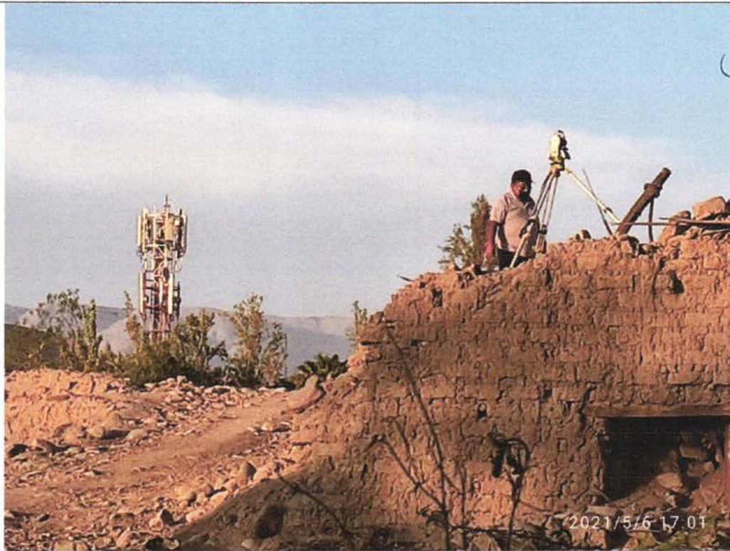
Vista del levantamiento topográfico
