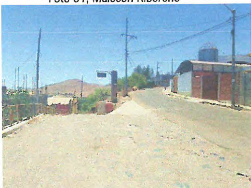
Foto 03, Vía Paisajista acceso a la bodega Paredes
