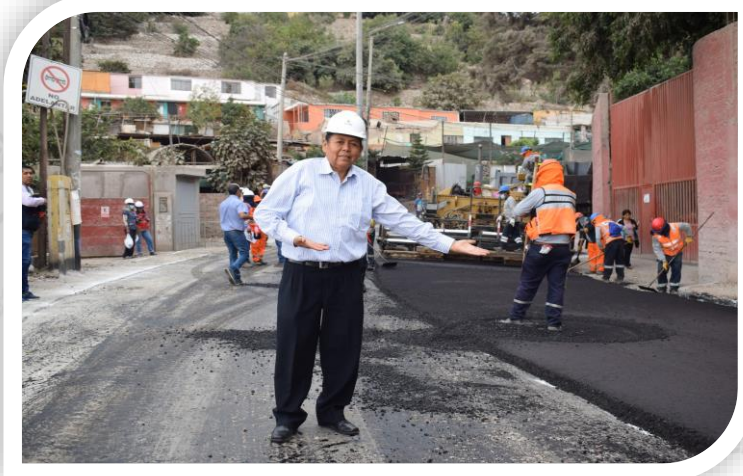
OBRA: MEJORAMIENTO DE LA CARRETERA VECINAL RUTA MO-518 TRAMO CENTRO POBLADO LOS ÁNGELES
