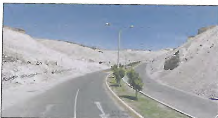
IMAGEN 22: INFRAESTRUCTURA VIAL AV. MINERA
