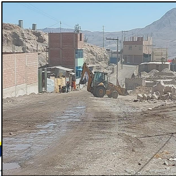
FIG. N°05: CARGUÍO Y ELIMINACIÓN DE MATERIAL EXCEDENTE Dprom. 10 Km.
