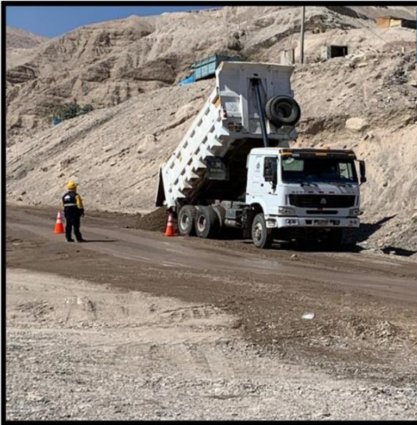
FIG. N°01: RELLENO DE MATERIAL PROPIO.
