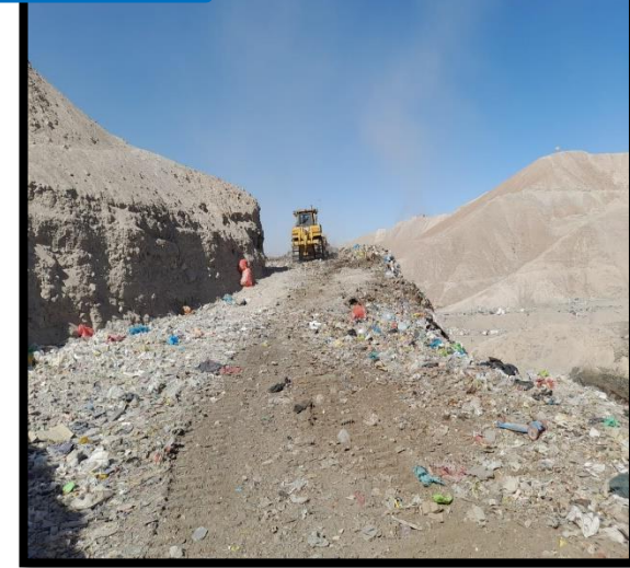
FIG. N°12: CORTE Y PERFILADO DE MATERIAL SUELTO.
