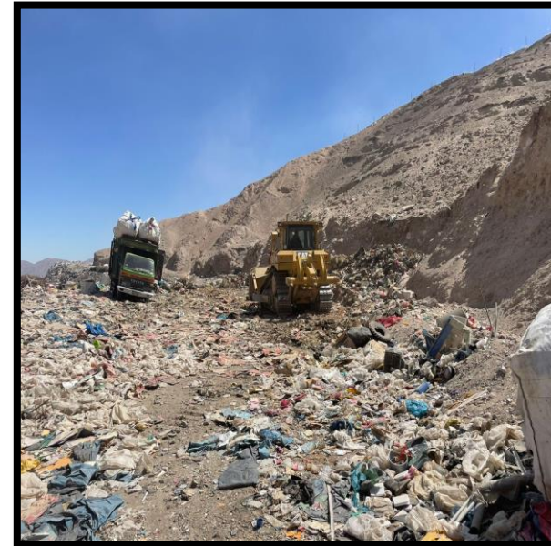
FIG. N°14: CORTE Y PERFILADO DE MATERIAL SUELTO.
