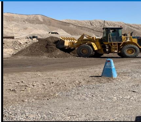
FIG N°02: PREPARACIÓN DE MATERIAL PROPIO PARA RELLENO.
