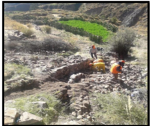
PARTIDA : EXCAVACION DE ZANJAS PARA CANAL ENTUBADO
