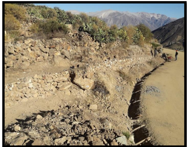
PARTIDA : CONSTRUCCION DE MUROS DE MAMPOSTERIA DE PIEDRA EN CANALES
