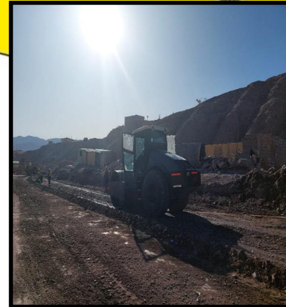
FIG. N°04: COMPACTACIÓN CON MATERIAL PROPIO PREPARADO .
