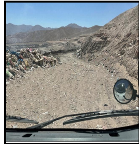
FIG. N°15: NIVELACION CON MATERIAL PROPIO PREPARADO .
