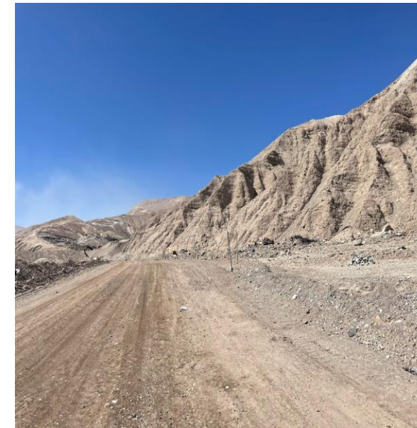
FIG. N°07: RELLENO, NIVELACIÓN Y COMPACTACIÓN CON MATERIAL PROPIO PREPARADO
