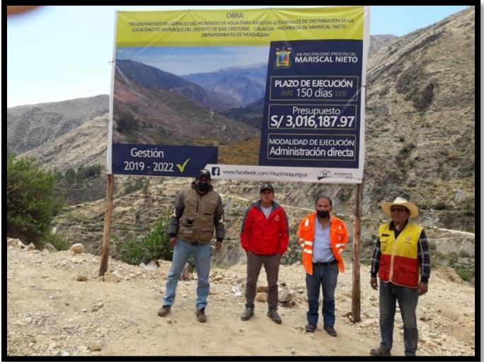
PARTIDA : CARTEL DE OBRA EN ZONA DEL PROYECTO
