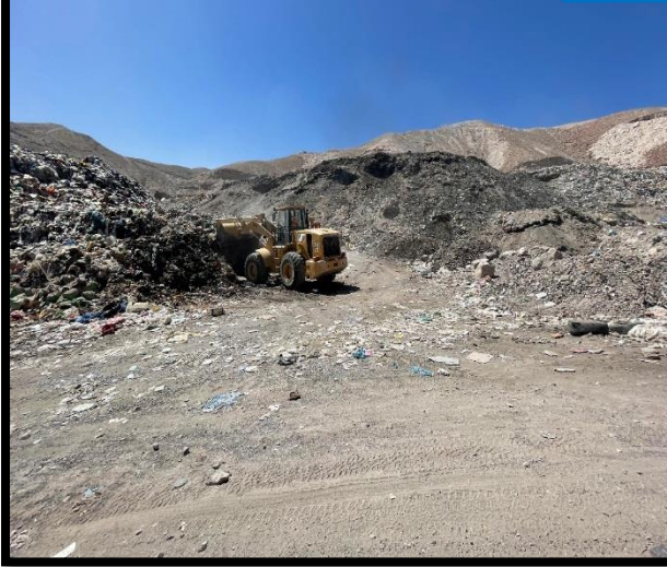
FIG. N°10: CORTE Y PERFILADO DE MATERIAL SUELTO..
