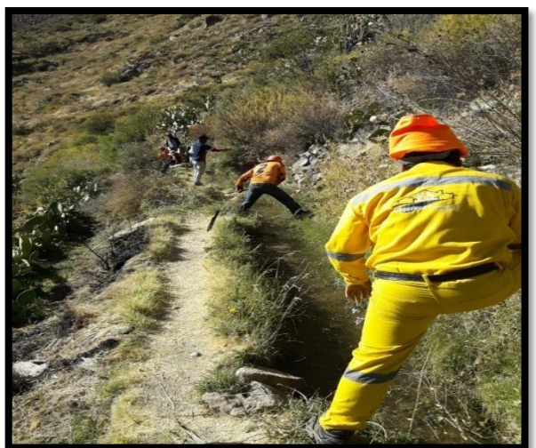
PARTIDA : LIMPIEZA DE TERRENO MANUAL EN CANALES EXISTENTES
