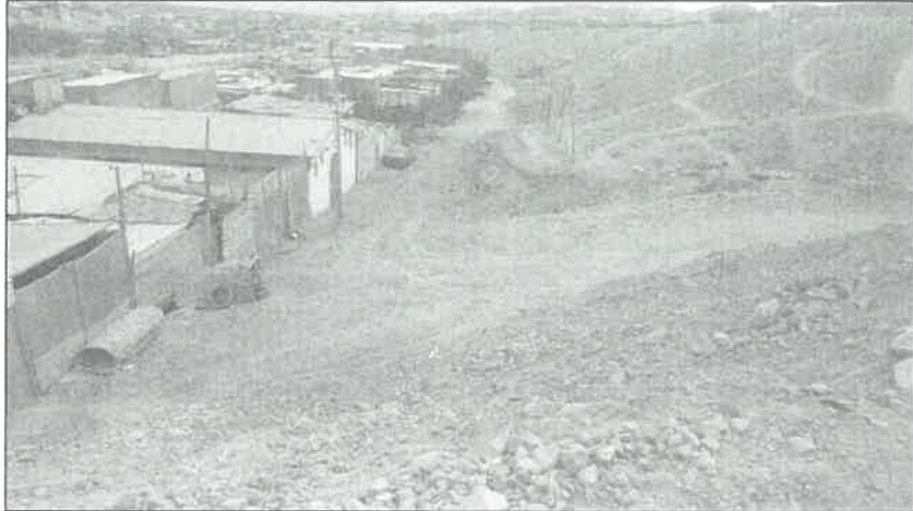
Foto 1 – Avenida 2, no cuenta con tratamiento, y por encontrarse frente a un talud, el desprendimiento de tierra perjudica a las viviendas colindantes.
