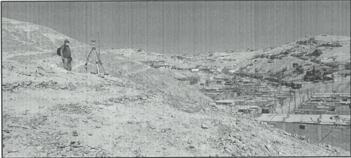
Foto N°1: Punto Base para el inicio del trabajo topográfico.
