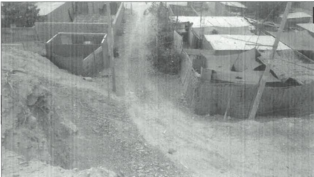
Foto 06 – Pasaje 5 vista desde la calle 4 parte superior.
